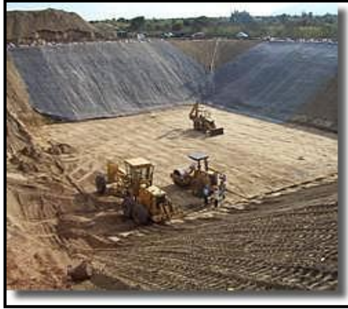
Figura 4 Construcción del Relleno Sanitario “Método de Trinchera” FUENTE: Tomada de (Conama, 2005)
