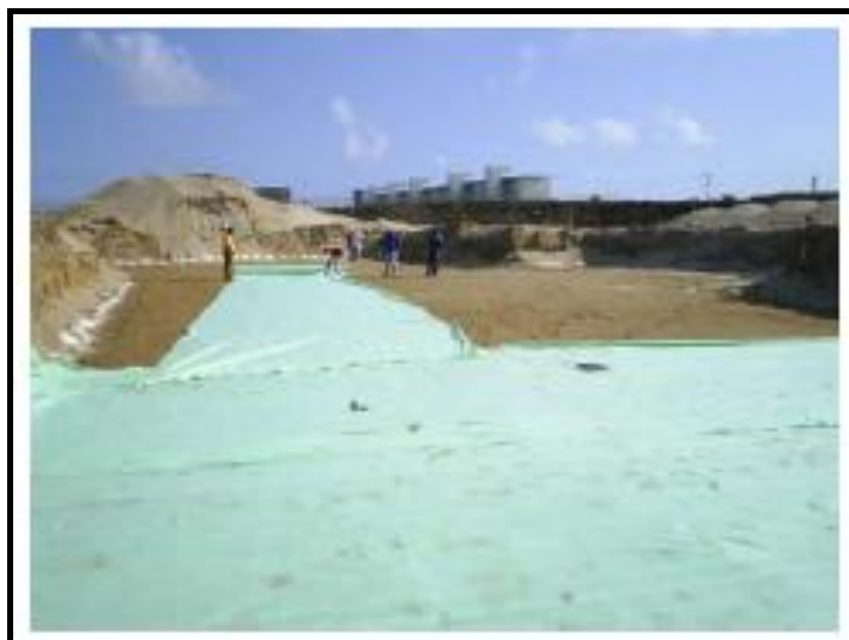
Figura 12 Colocación de geotextil
