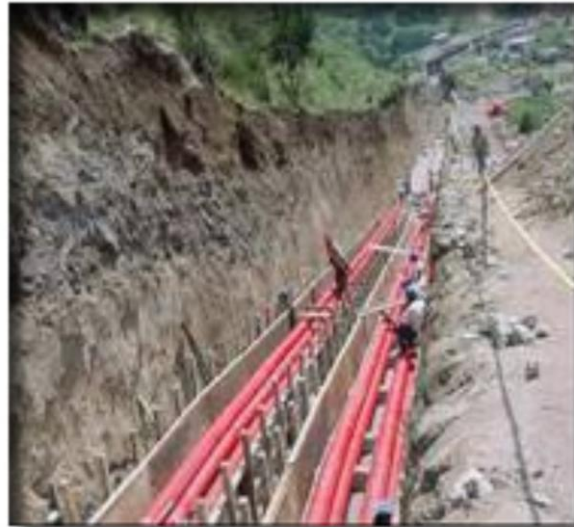
Figura 1.7.- Implementación de una red subterránea
