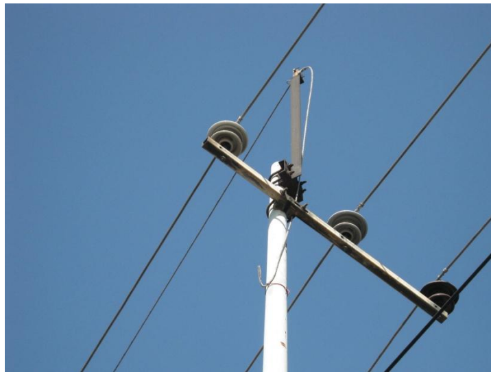
Figura AN.13.- Hilo de guarda sin aterrizar
