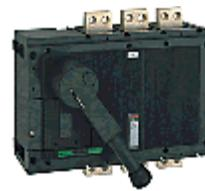
Es un dispositivo en general operado manualmente (aunque puede disponer de disparo eléctrico) y tiene dos posiciones cerrado-abierto. Está diseñado para cerrar o abrir circuitos en carga en condiciones normales de servicio (sin falla) y por lo tanto se le asignan corrientes nominales de cierre y apertura para las condiciones normales de servicio.
