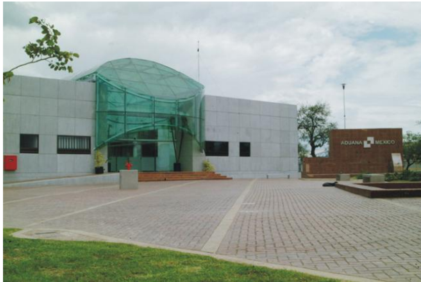
Figura 16. Oficinas de la aduana en el puerto interior Silao, Guanajuato
