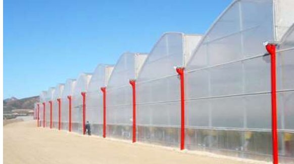
Figura 2.1.6.1 Invernadero tipo diente de sierra
