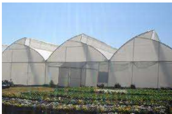
Figura 2.1.9.1 Invernadero de techo curvo
