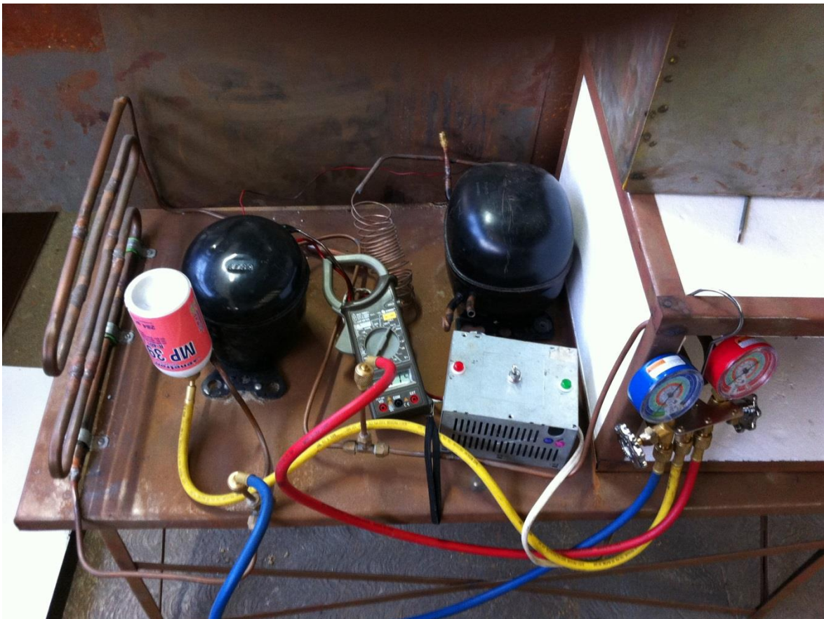
Figura 27. Llenado de refrigerante al sistema
