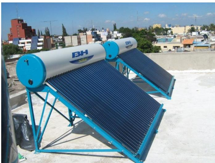
Figura 22 - Colectores de tubos evacuados<sup>48</sup>.
