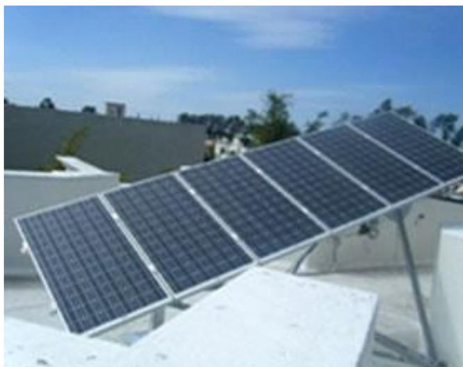
Figura 19 - Instalación Fotovoltaica<sup>45</sup> tipo Tracker por Desmex Solar: 1.05 kW
