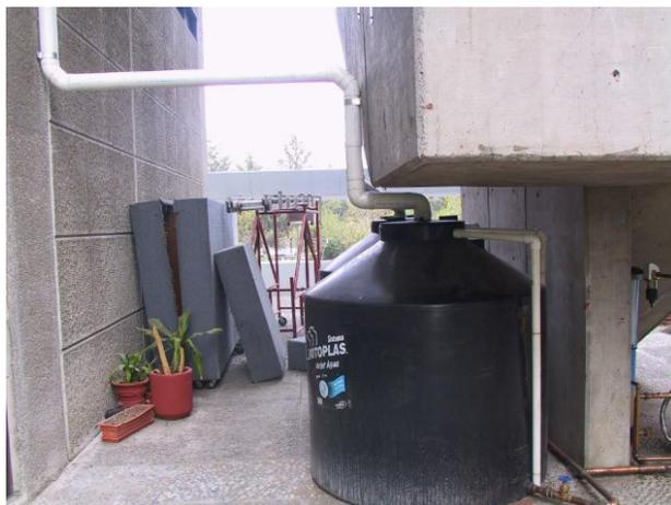
Figura 18 - Cisterna prefabricada de plástico<sup>42</sup>
