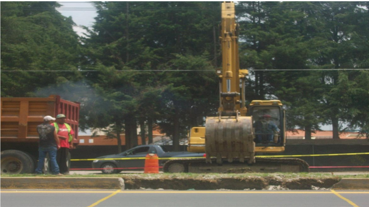
Fig. II.1. Trazo de zapata para excavación
