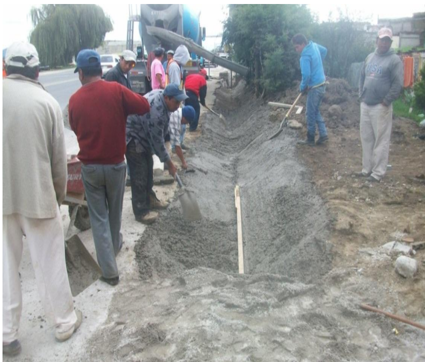
Fig. 1.3.1. Se observa la construcción de cunetas.
