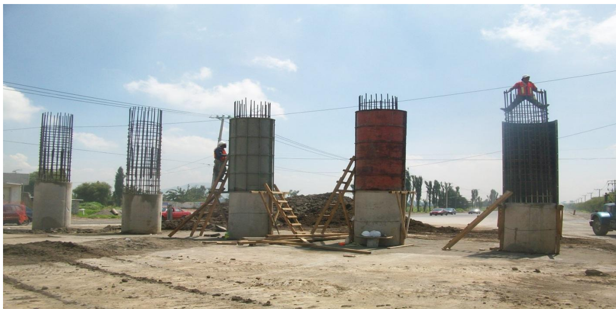
Fig. II.3.2 Se observa el alineamiento del acero
