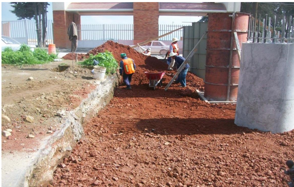
Fig. II.6.10 Relleno con tezontle de 3" a 6".
