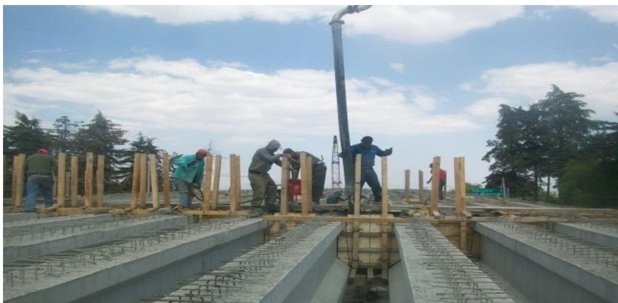
Fig. II.6.2 Se observa el colado con bomba telescópica.
