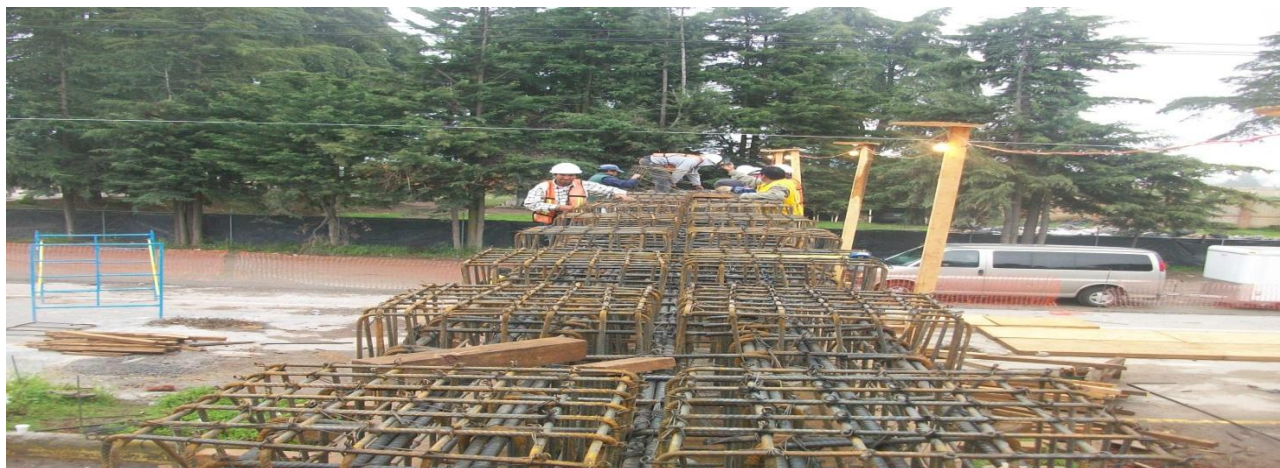
Fig. III 2.2 se puede observar el diámetro del acero que está en los bancos del cabezal.
