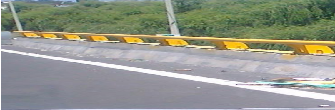
Fig. III.3.2 Se puede observar el parapeto metálico utilizado
