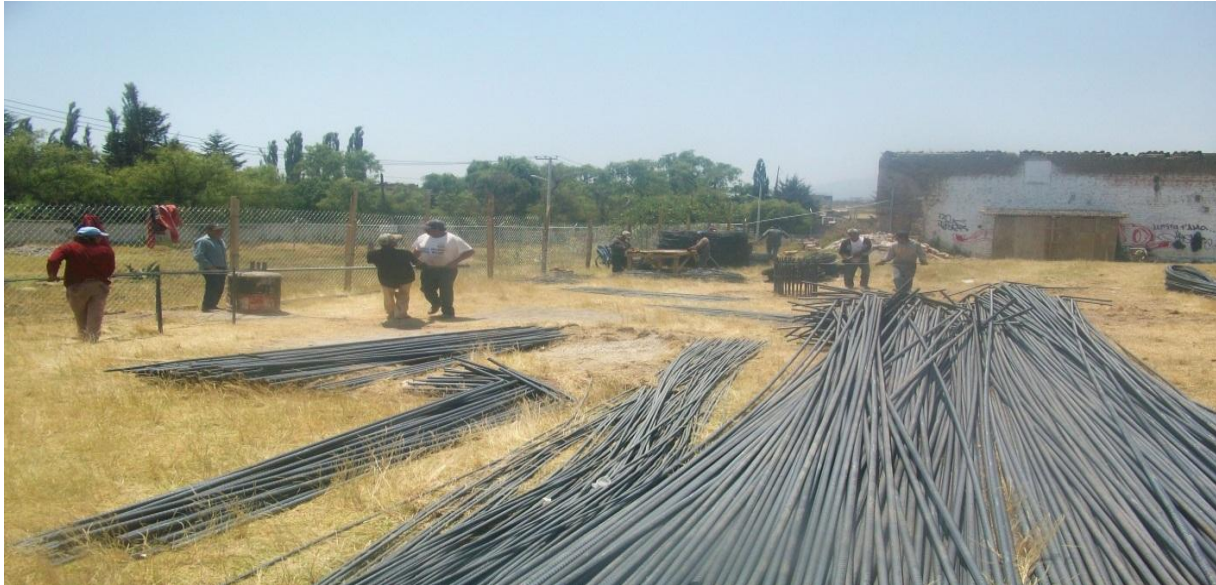
Fig. III.2.3 se puede observar el almacenamiento del acero
