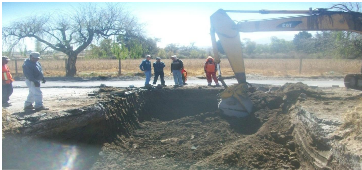
Fig. II.1.1. Excavación de zapatas por medios mecánicos
