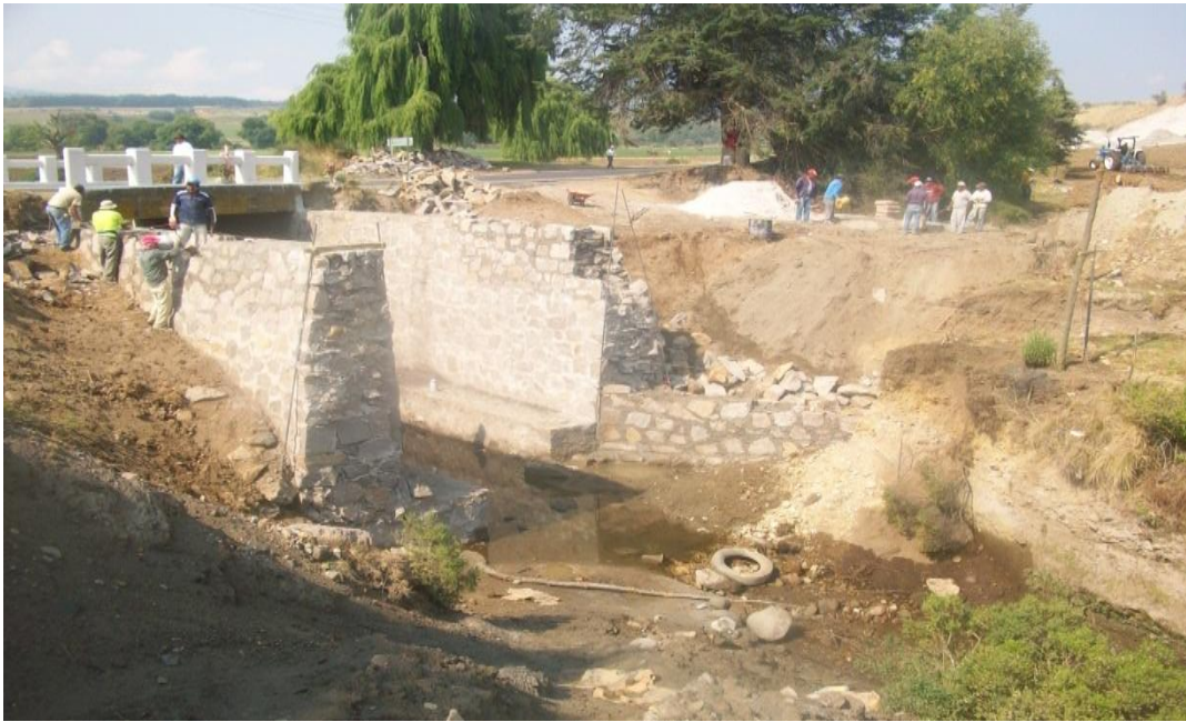
Fig. 1.3.6. Ampliación del puente del tramo troncal.
