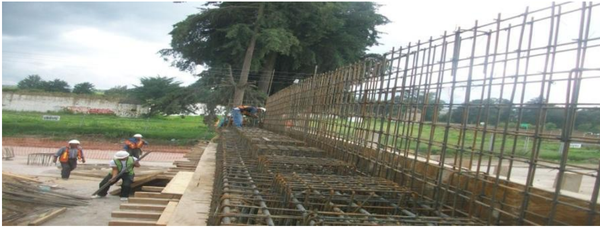
Fig. II.5.9 Construcción de muro entre losa de aproximación y traveses AASHTO.
