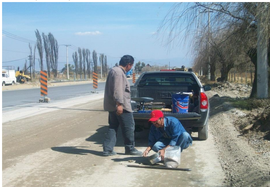
Fig. II.6.5 Obtención de muestras de la base
