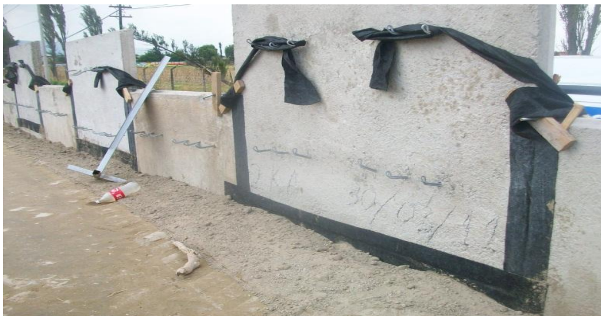
Fig. II.5.5 Colocación de juntas de neopreno en muros.
