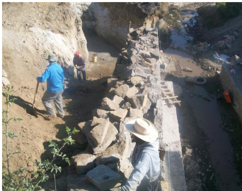
Fig. I.3.4. Ampliación de las obras de captación de aguas pluviales.
