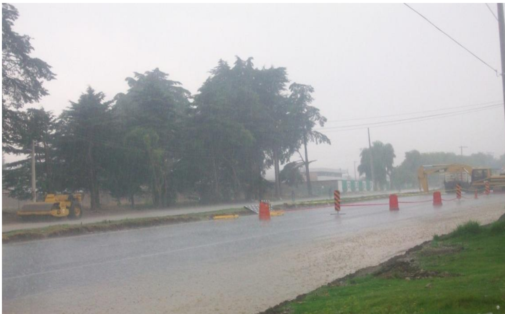
Fig. I.5.1. Se observan los trafitambos para protección vial.
