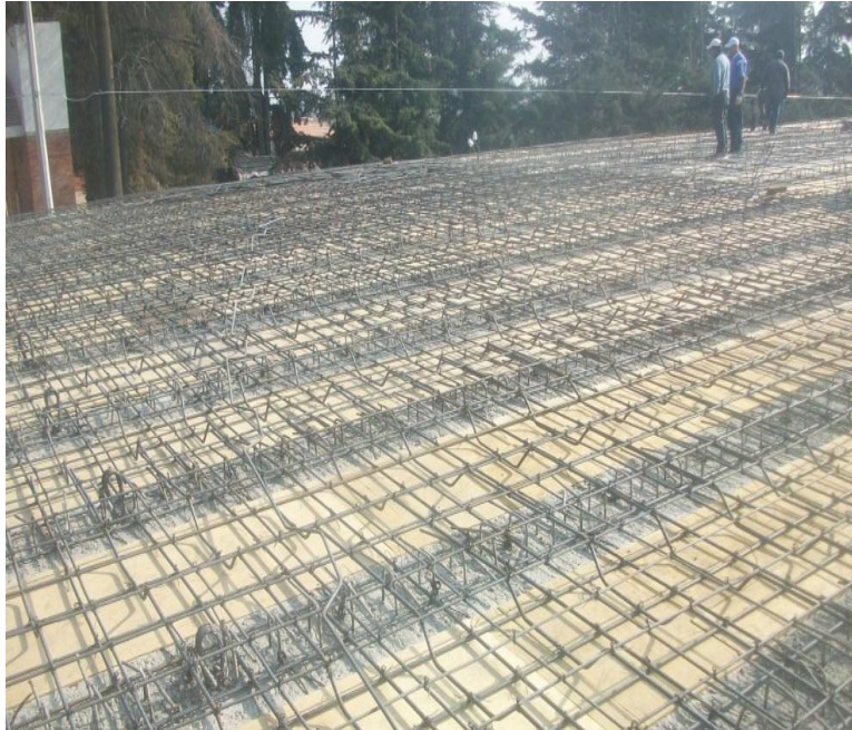
Fig. 1.2.8. Se observa la cimbra entre la separación de trabes AASHTO.
