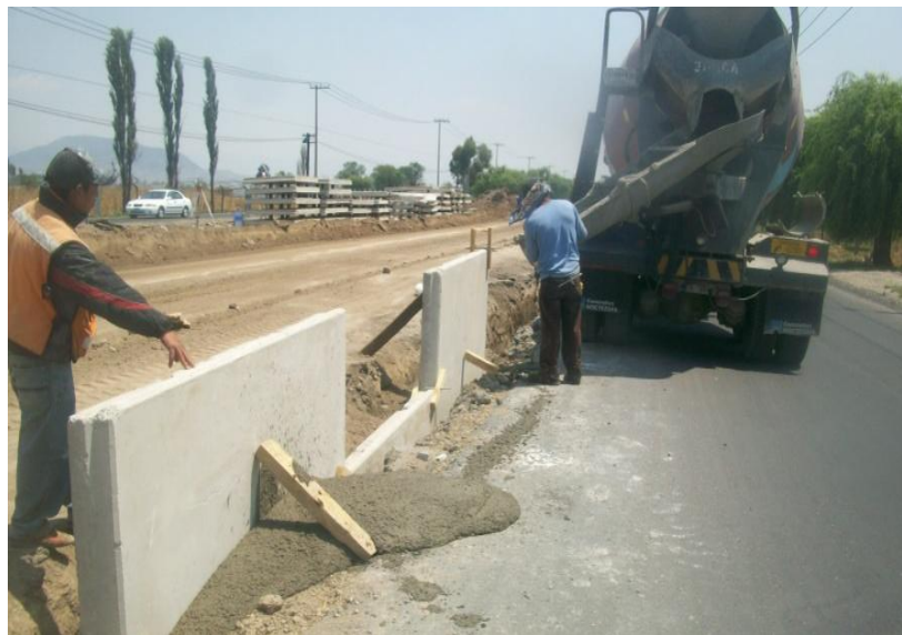
Fig. I.2.7. Se observa parte del relleno con tepetate.
