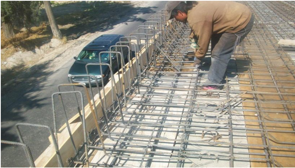
Fig. II.6.4 Armado de la losa y parapeto.
