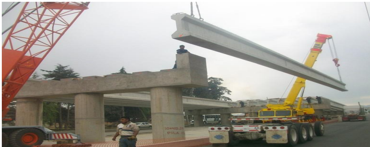
Fig. II.5.1 Montaje de traveses AASHTO con dos grúas.
