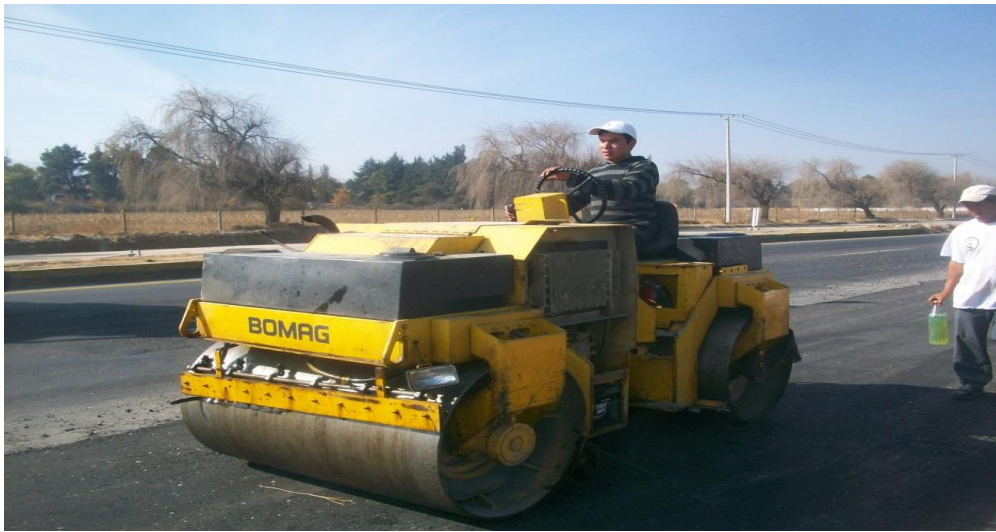
Fig. II.6.8 Se realiza la compactación de la carpeta.
