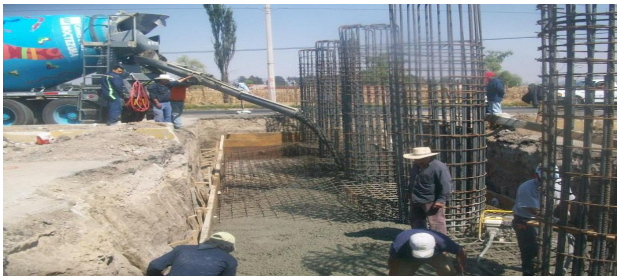
Fig. II.3.1 Colado de zapatas en tiro directo.
