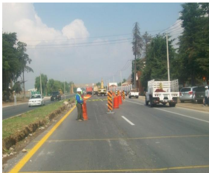
Fig. I.1.2. se puede observar el trazo de zapatas.
