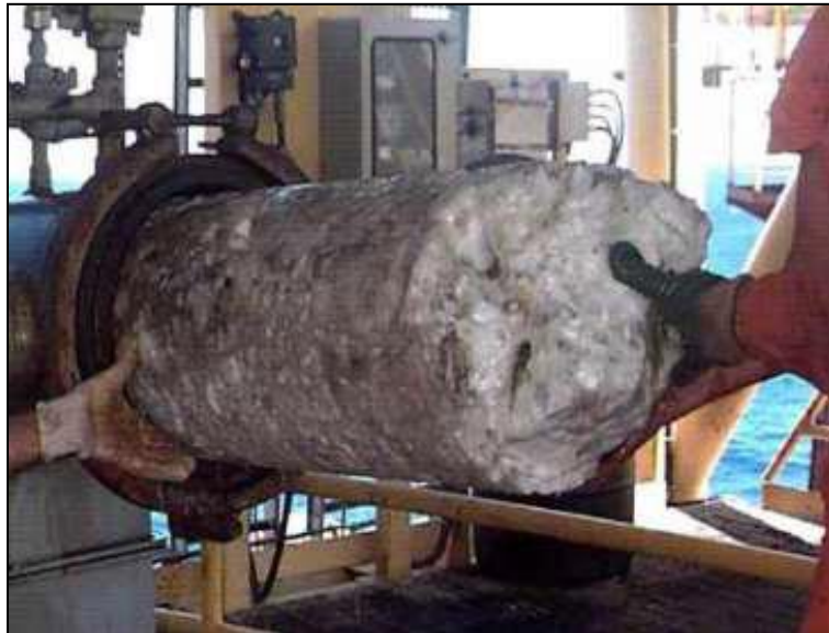
Fig B.1. Tubería con Problema de Hidratos de Gas
