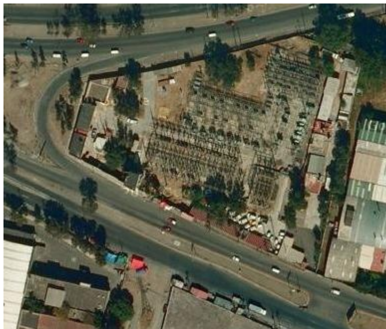
Figura 2.7 Vista aérea de la subestación La Paz
