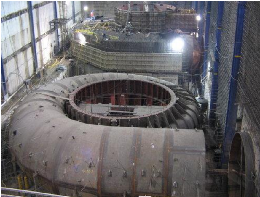
Figura I.1 Turbinas tipo Francis en proceso de instalación.
