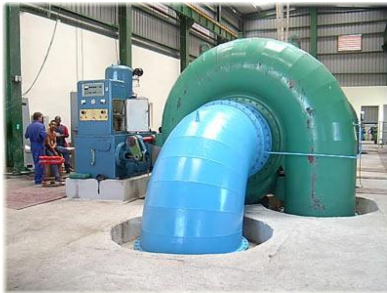
Figura I.6 Vista exterior e interior de un miniproyecto hidroeléctrico.
