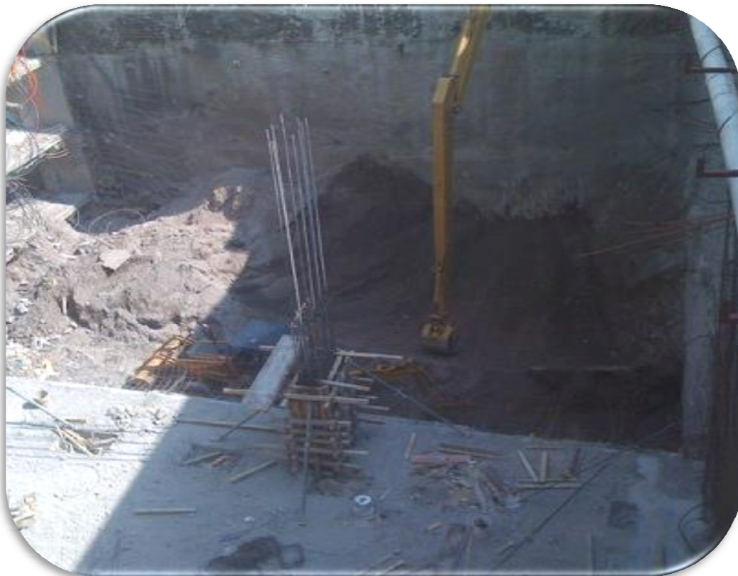
Figura 5.1 a3 Excavación de la zanja con retroexcavadora
