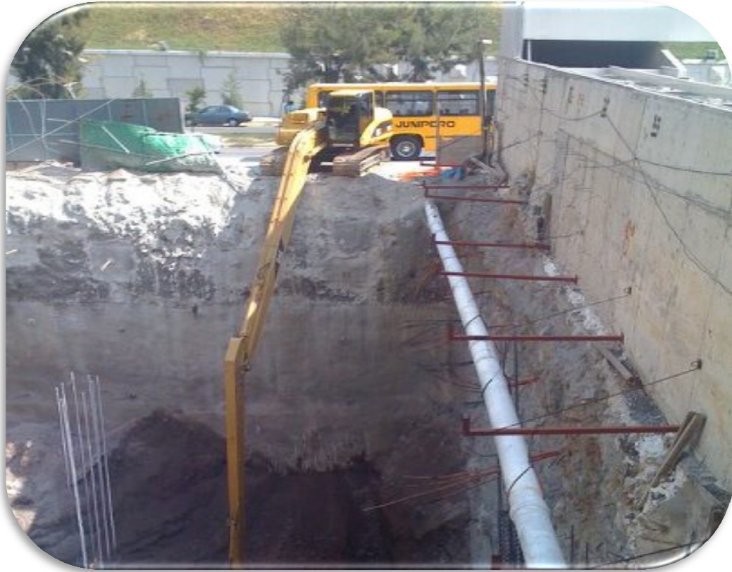
Figura 5.1 a2 Excavación de la zanja con retroexcavadora
