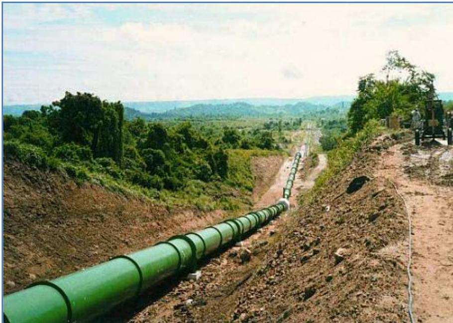
Figura 2.5 Línea de conducción de agua potable
