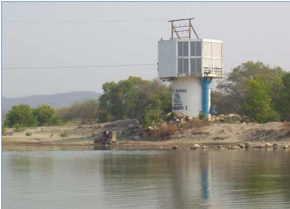
Figura 2.4 Pozo radial sistema de abastecimiento Papagayo I
