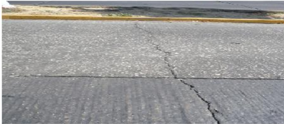
Imagen 4.27 Grietas transversales.
