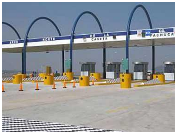
Imagen 6.13 Casetas de la carretera “Arco Norte”
