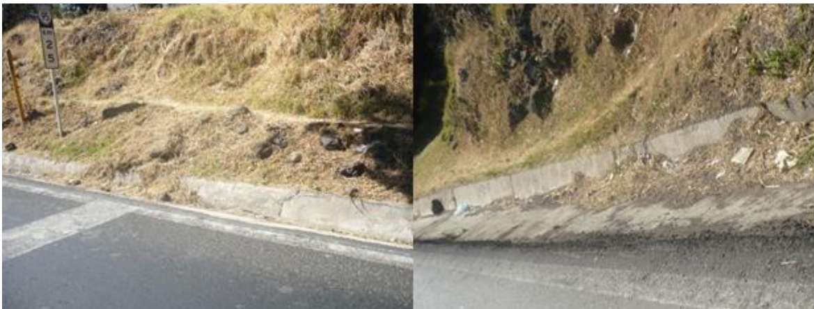
Imagen 4.41 Azolve en el drenaje superficial.
