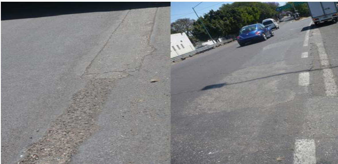
Imagen 4.20 Instalaciones y servicios.
