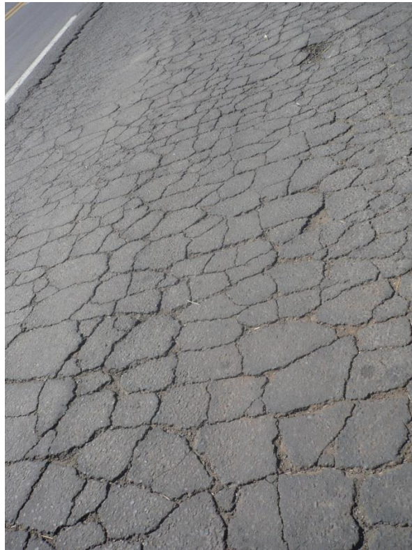
Imagen 4.3 Desintegración.
