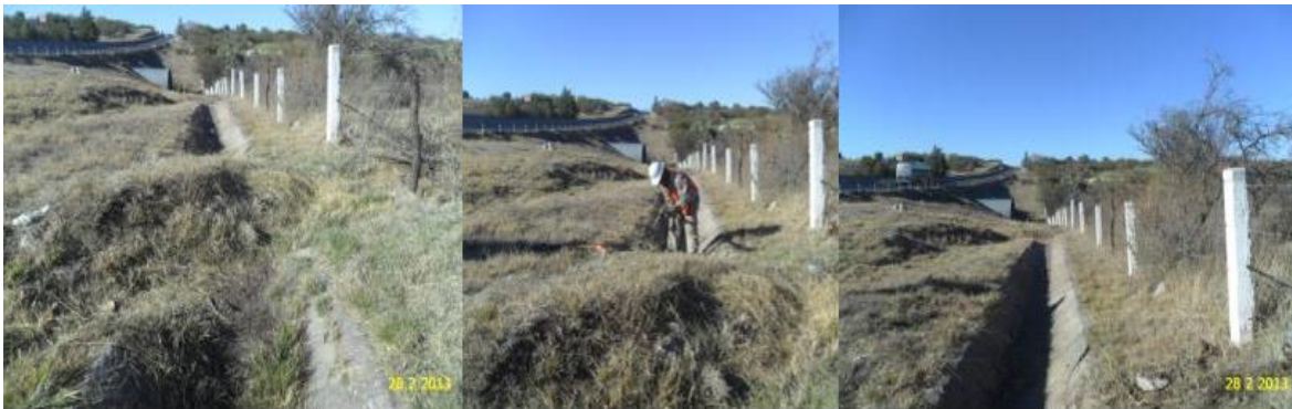
Imagen 5.5 Desazolve de contracunetas.
