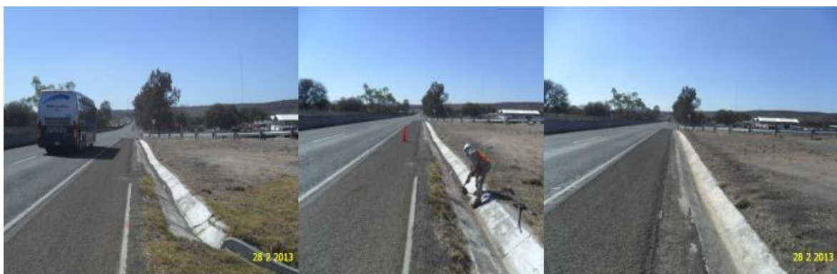
Imagen 5.3 Limpieza de cunetas.
