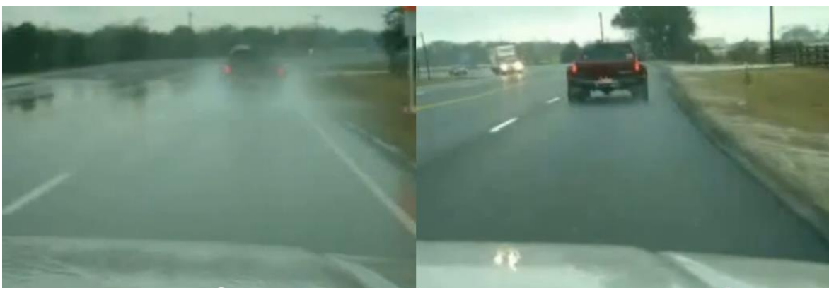
Imagen 5.9 Antes y después del tratamiento "Open Grade".
