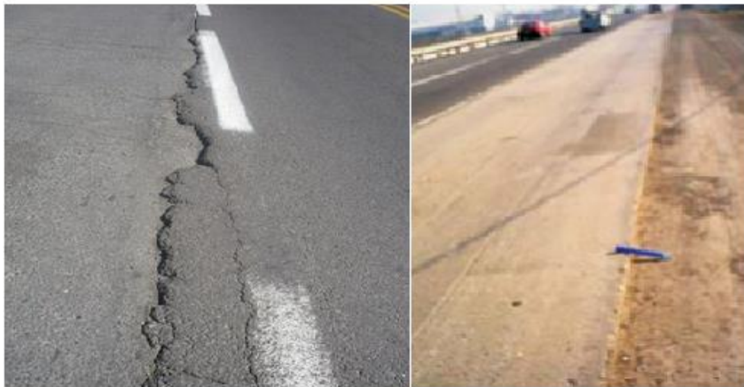
Imagen 4.38 Descenso de la berma.
