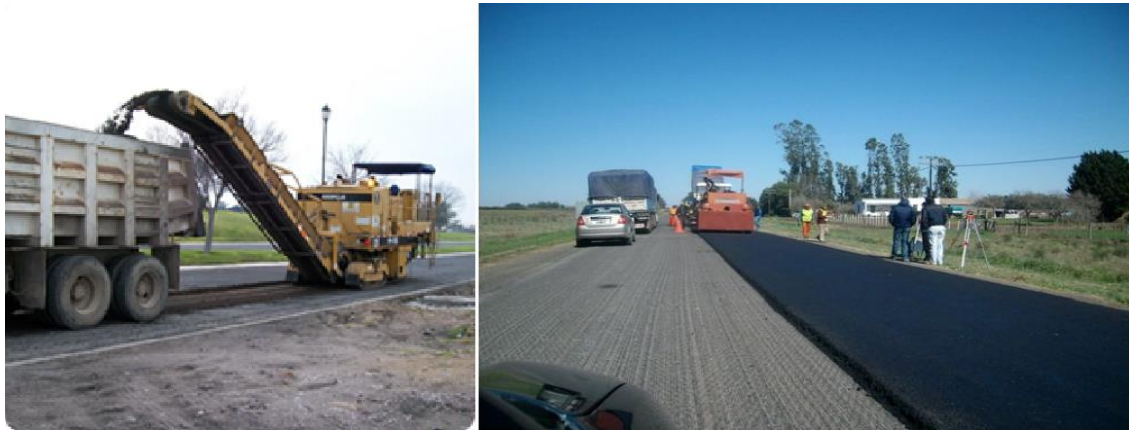
Imagen 5.10 Fresado de la superficie de rodamiento.
