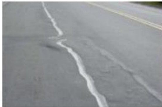
Imagen 4.10 Ondulaciones transversales.
