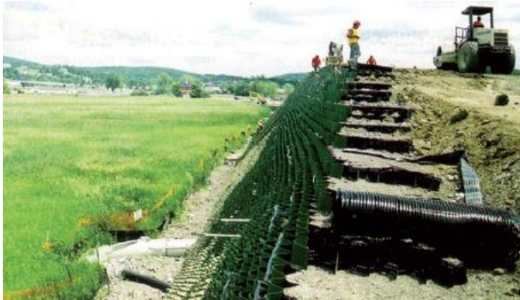
Imagen 6.3 Instalación de las geoceldas.
