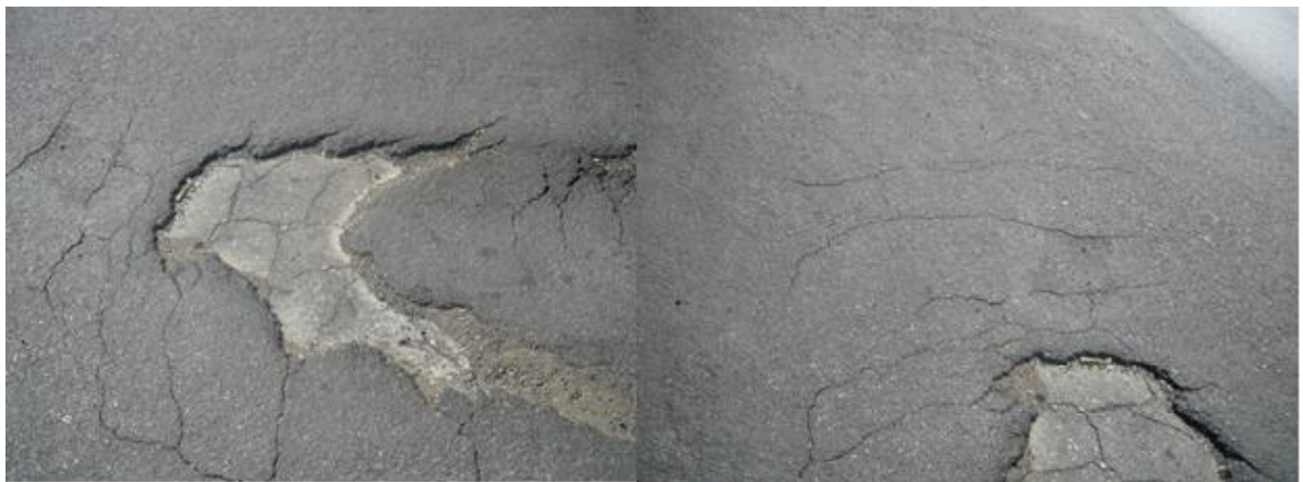
Imagen 4.17 Grietas parabólicas.
