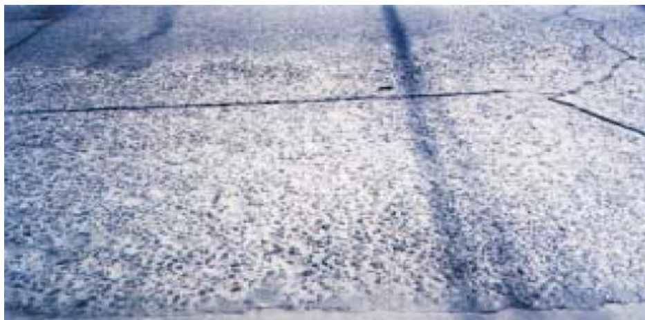
Imagen 4.30 Desintegración.
