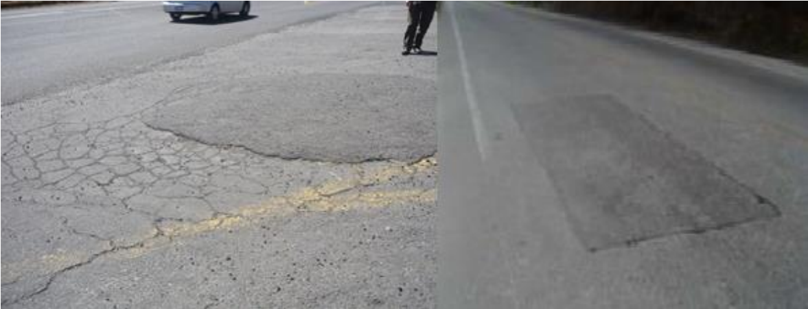
Imagen 4.21 Reparación de la estructura del pavimento.
