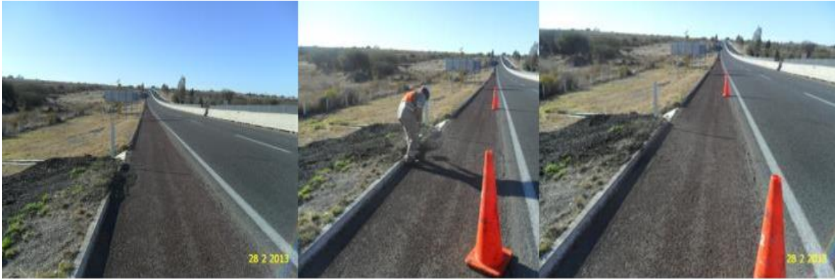
Imagen 5.6 Reposición de bordillo.
