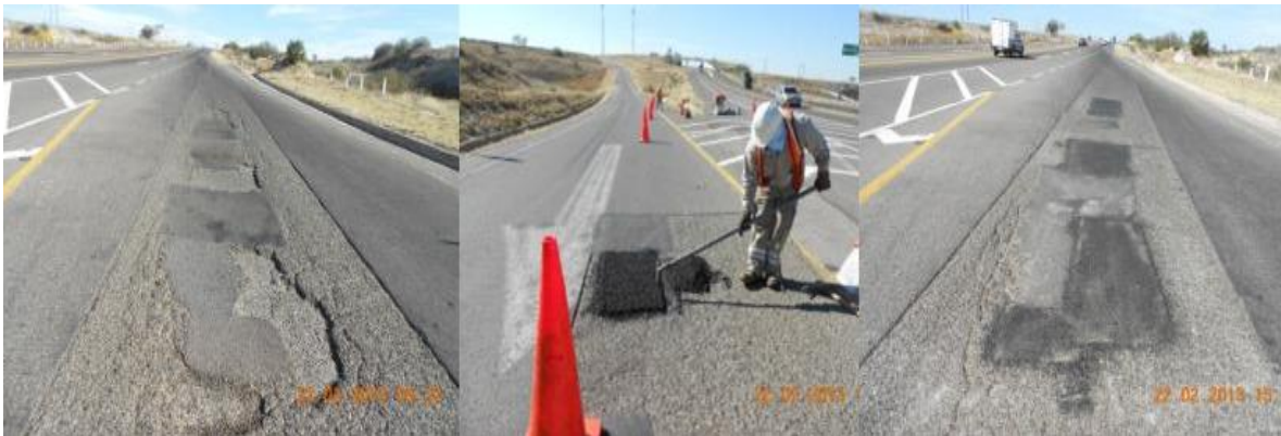
Imagen 5.2 Reparación del bacheo superficial.
