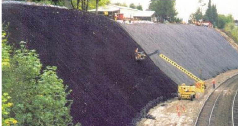
Imagen 6.4 Protección de taludes con geosintéticos e hidrosiembra.
