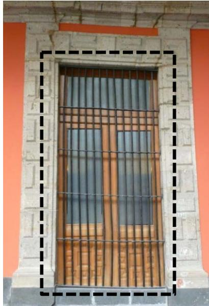
*Figura 2.7 Marco y herrería de ventana con deformaciones, Patio Central.*
