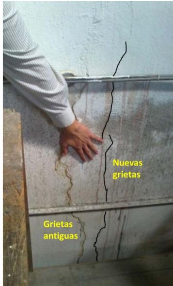
*Figura 5.3 Detalle de agrietamientos bajo los extensómetros 3 y 7*
