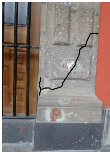
*Figura 2.8 Agrietamientos en elementos de cantera, marco de ventana en el Patio Central*
