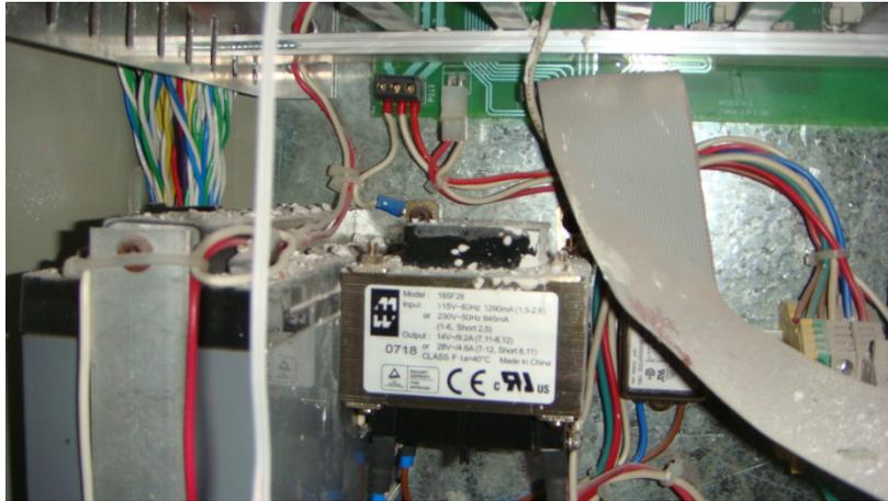
*Figura 5.7 Interior de la estación 8, presencia de escombros y polvo*
