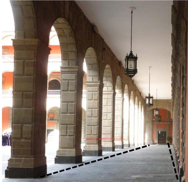
*Figura 2.9 Desniveles en columnas, costado norte del Patio Central.*
