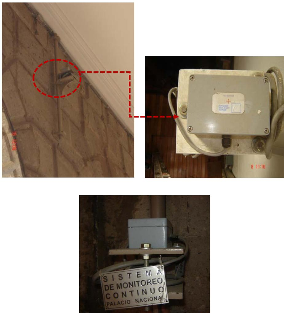
*Figura 3.5 Inclinómetros instalados en Palacio Nacional.*
