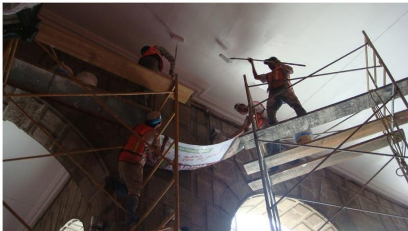
*Figura 5.6 Trabajos de aplicación de pintura*
