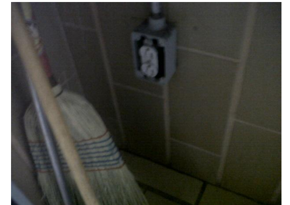
Foto 14. Tapa inexistente en enchufe.
