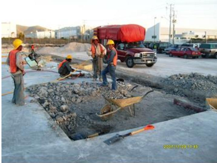
FIG. 16 .- DEMOLICIÓN DE FIRME MAL COLADO
