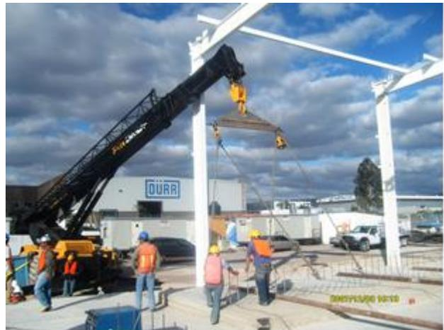
FIG. 34 .- MANIOBRA PARA IZAJE DE MURO
