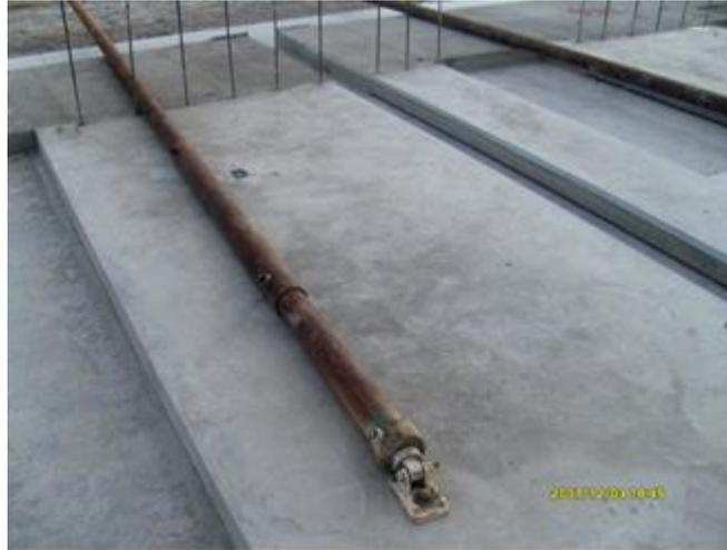
FIG. 30 .- FIJACIÓN DE PUNTALES AL MURO
