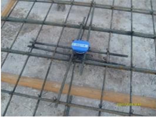
FIG.. 26 .- ELEMENTO PARA IZAJE DEL MURO
