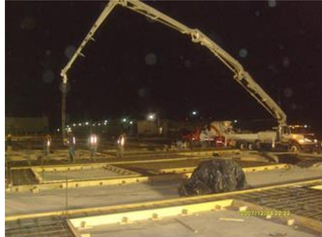
FIG. 32 .- COLOCACIÓN DE CONCRETO EN MURO
