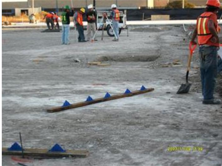
FIG. 9.- TRAZO Y EXCAVACIÓN DE ZAPATAS
