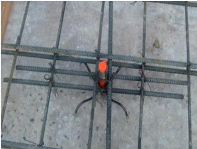
FIG. 28 .- ELEMENTOS PARA EL PLOMEADO
