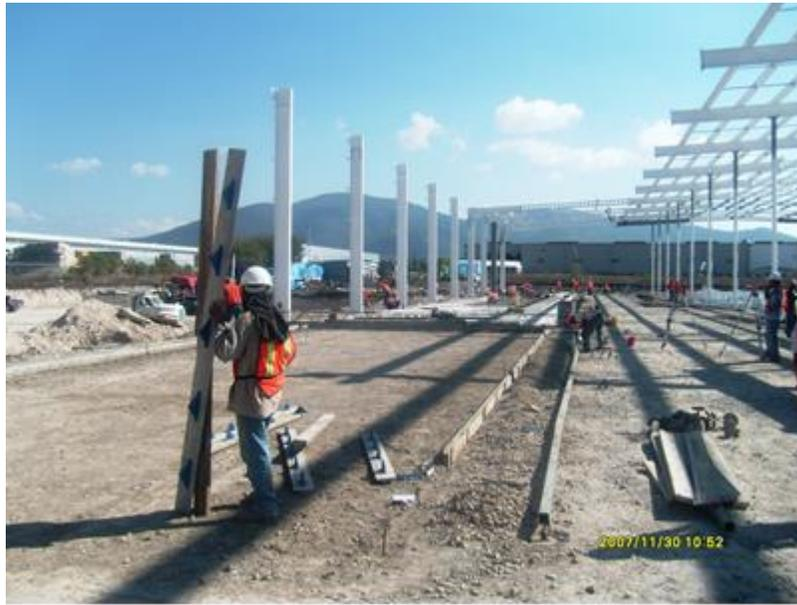
FIG. 13 CIMBRADO PARA EL COLADO DEL FIRME
