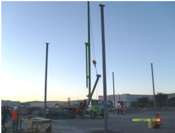
FIG. 37 .- COLOCACIÓN DE COLUMNAS METÁLICAS INTERIORES
