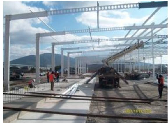
FIG. 39 .- COLOCACION DE TRABES METÁLICAS
