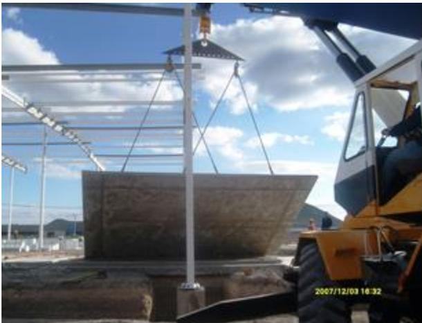
FIG. 33 .- IZAJE Y COLOCACIÓN DE MURO
