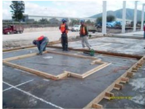
FIG. 18 .- COLOCACIÓN DE CIMBRA PARA MUROS
