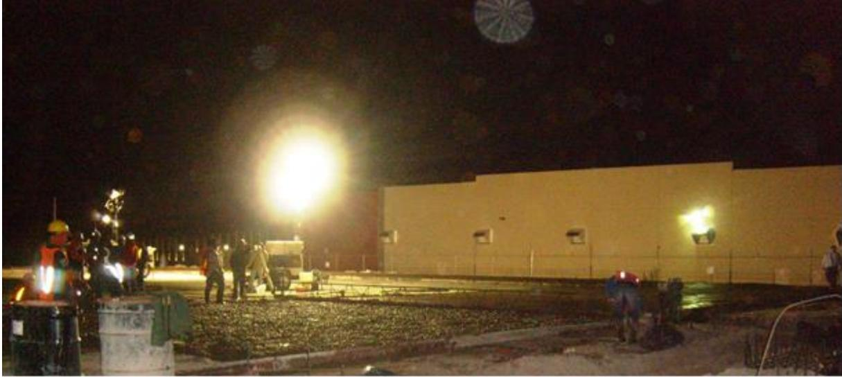
FIG. 14 .- COLOCACIÓN DEL CONCRETO EN FIRMES
