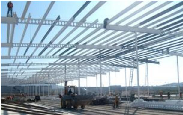
FIG. 40.- COLOCACIÓN DE POLINERÍA
