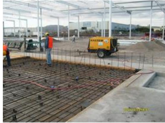
FIG. 25 .- CALZADO DEL ACERO DE REFUERZO
