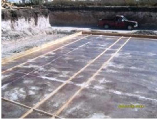
FIG. 19.- APLICACIÓN DE LIQUIDO DESMOLDANTE
