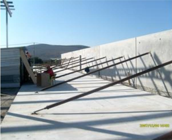
FIG. 35 .- PLOMEADO DE MUROS
