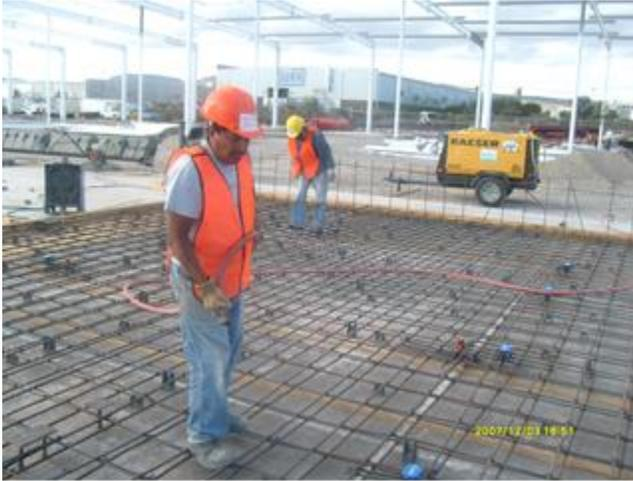
FIG. 31 .- LIMPIEZA FINA DEL MURO A COLAR
