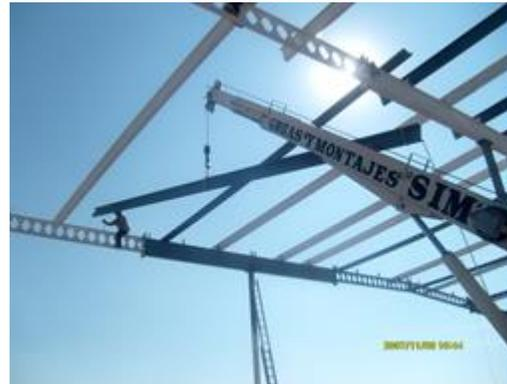
FIG. 41 .- MONTAJE DE TECHUMBRE
