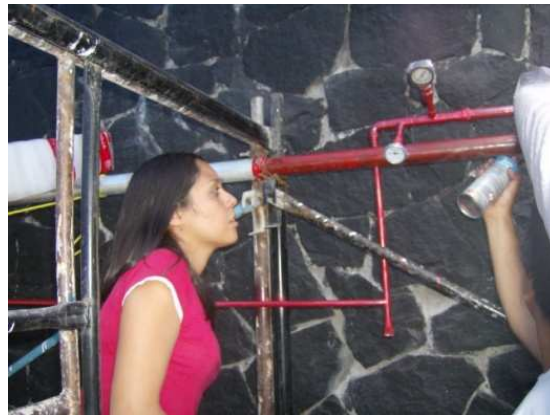
FIGURA 3.9. Identificación de tuberías de salida
