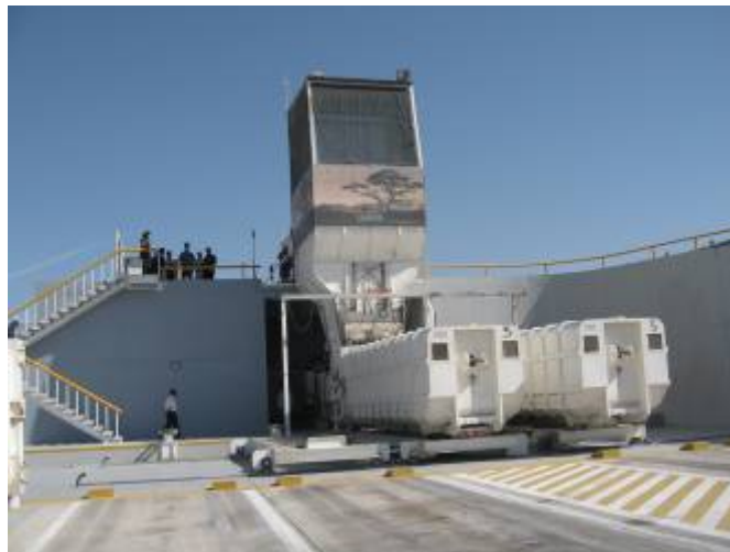
Figura 3.2 Estación de transferencia con mecanismo de compactación, Aguascalientes
