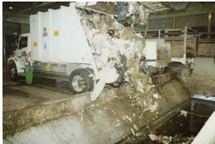
Figura 3.1 Estación de transferencia de carga directa, México DF
