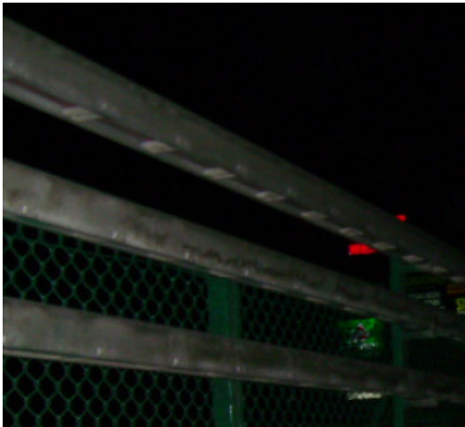
Figura II.1 Charolas de 15cm de ancho que contienen cables de 23 kv expuestos a la intemperie.
