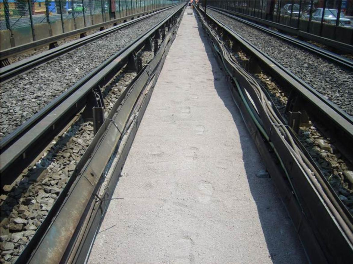
Figura III.32 Arena colocada sobre el banco de ductos al ras de los prefabricados.
