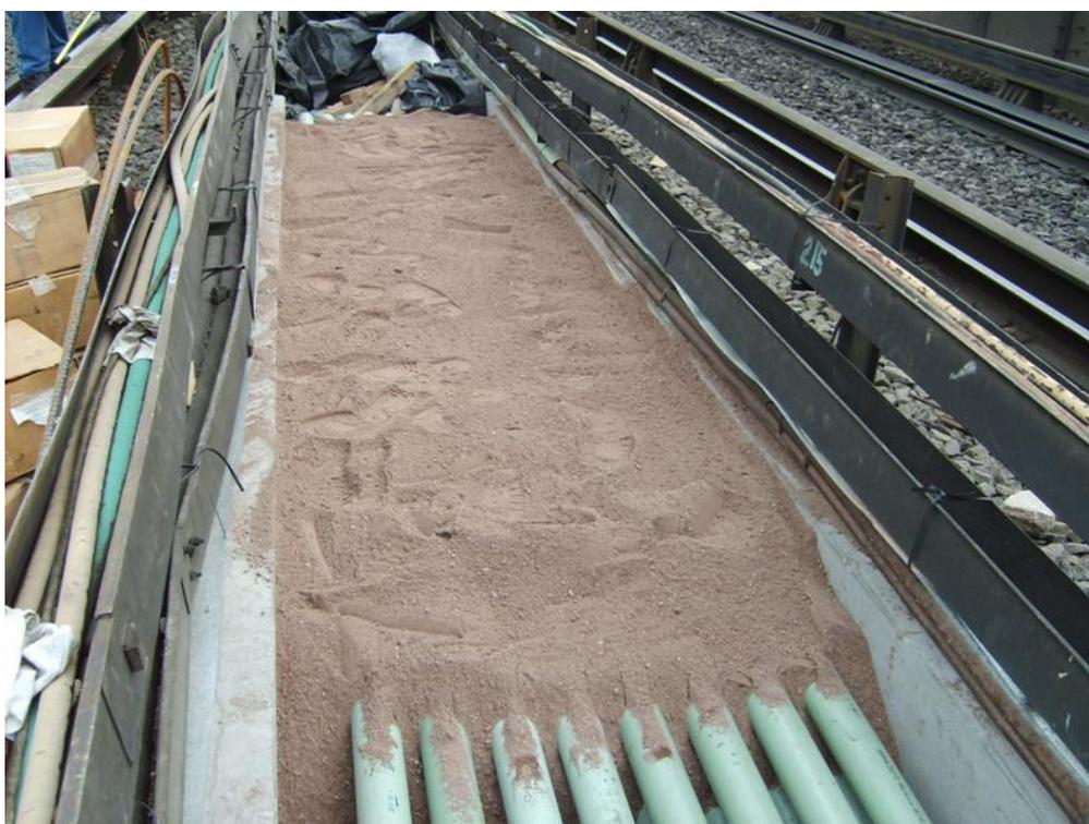
Figura III.29 Arena sobre banco de ductos
