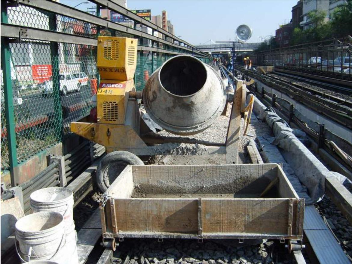
Figura III.23 Revolvedora para realizar concreto en obra.
