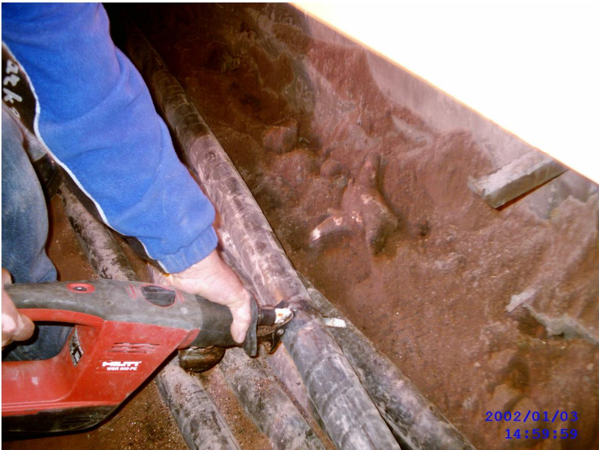
Figura III.6 Corte en secciones de cable tripolar fuera de servicio embebido en arena térmica.
