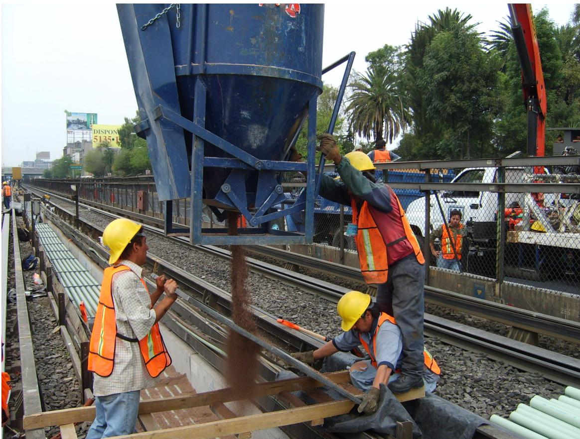
Figura III.27 Descarga de arena sobre banco de ductos
