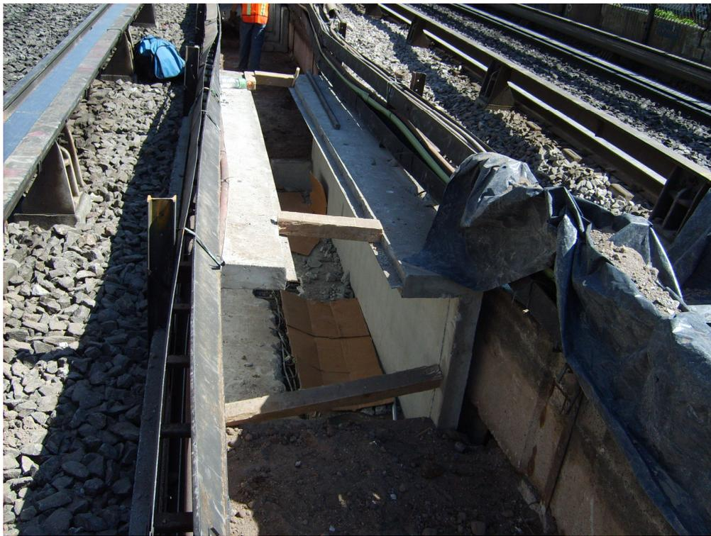
Figura III.22 Apuntalamiento de un prefabricado tipo registro.
