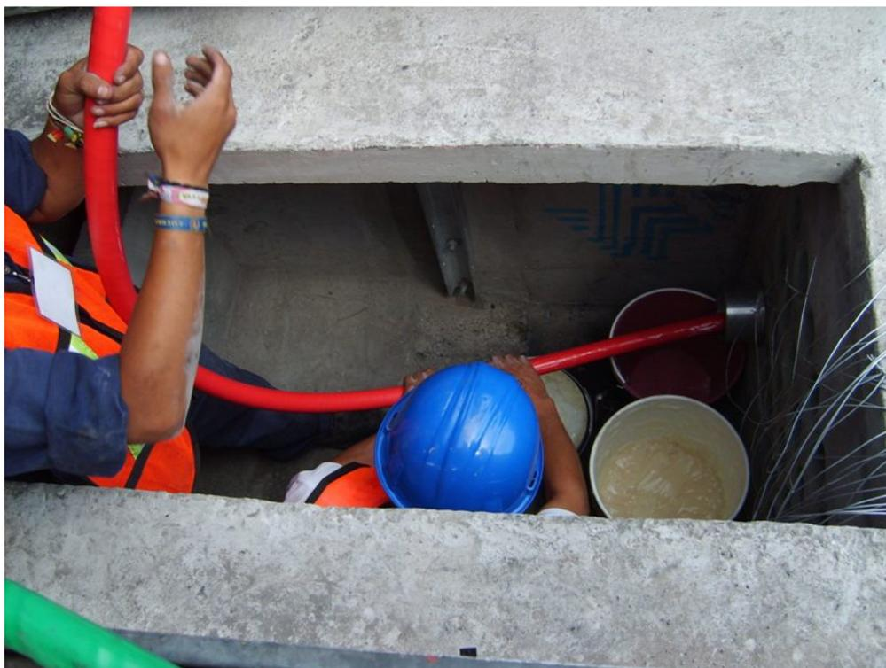
Figura III.38 Lubricación y guiado del cable a través de los registros
