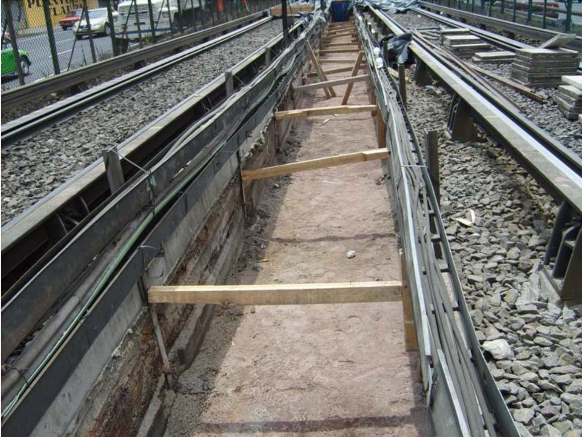
Figura III.12 Apuntalamiento de paredes de excavación.
