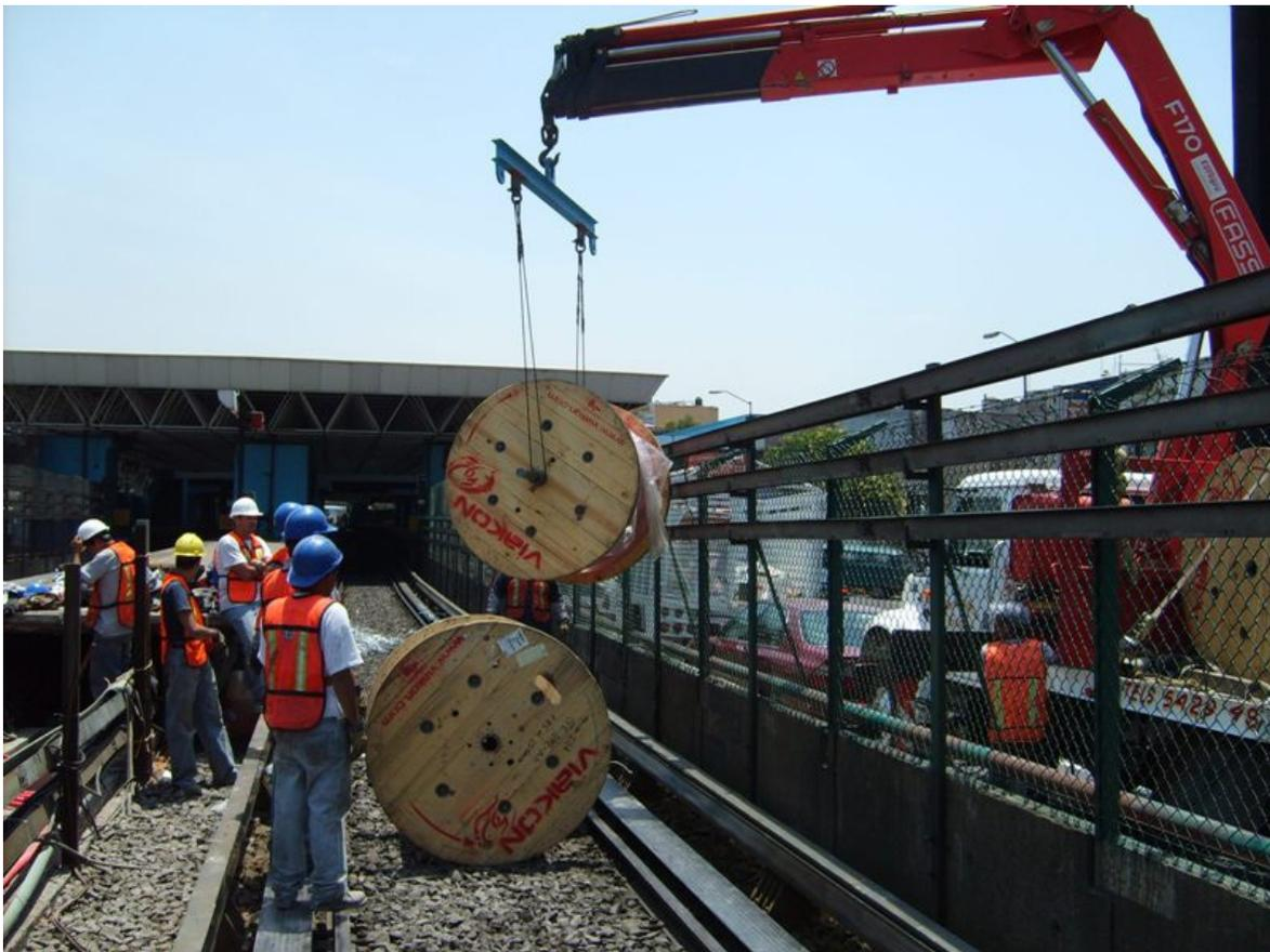
Figura III.35 Colocación de rollos de cable de 23 kv en el interior de la línea.
