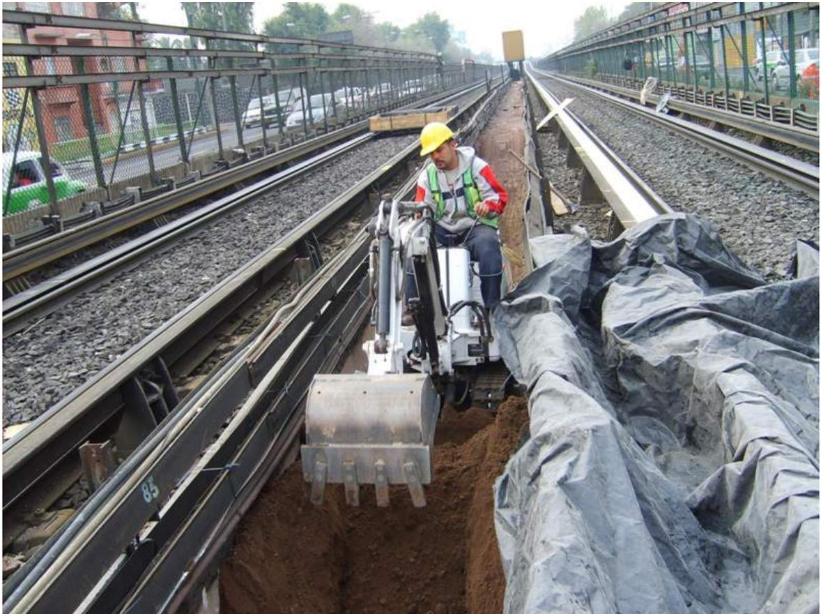
Figura III.9 Excavación superficial por método mecánico.
