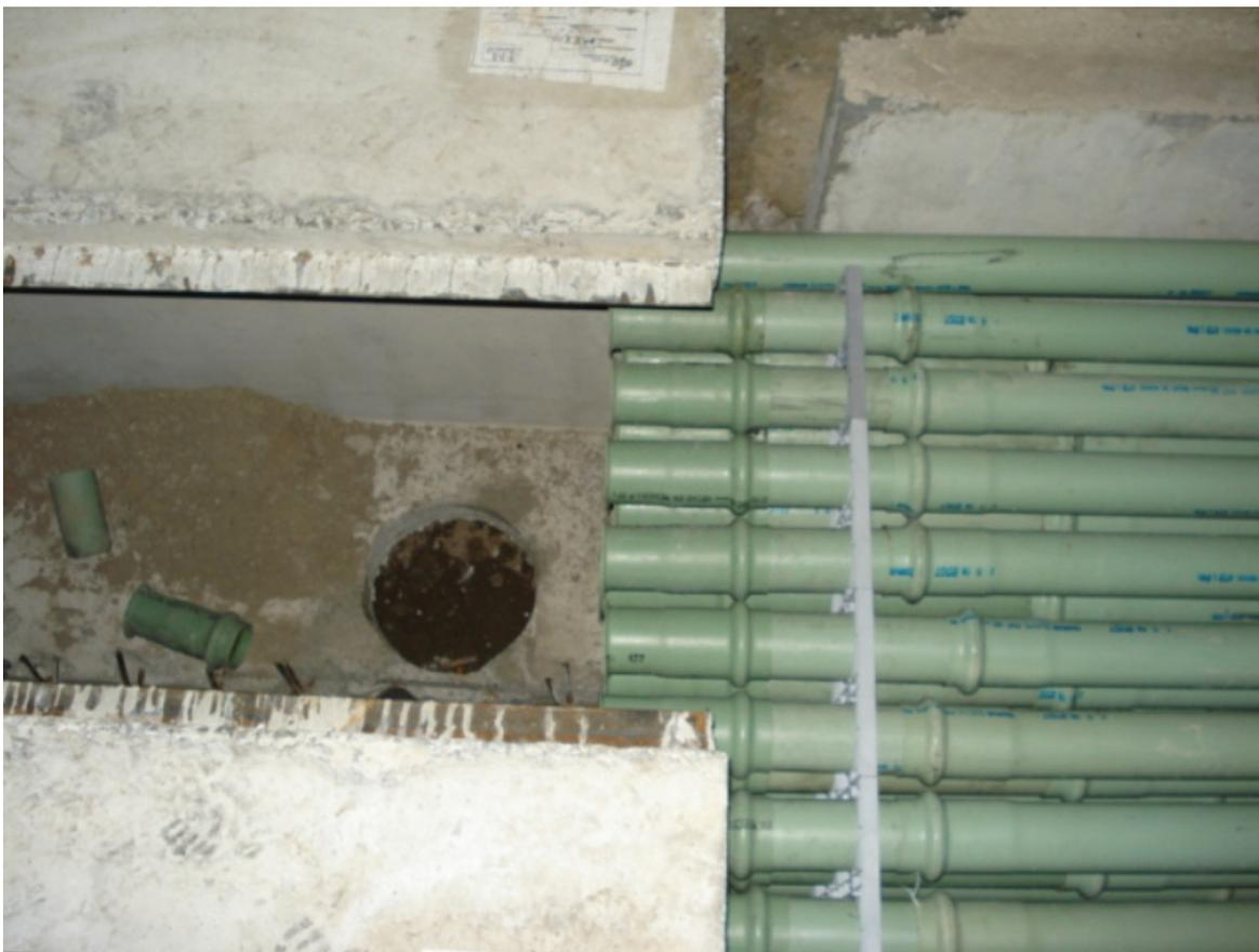
Figura III.30 Preparaciones para emboquillado en registros
