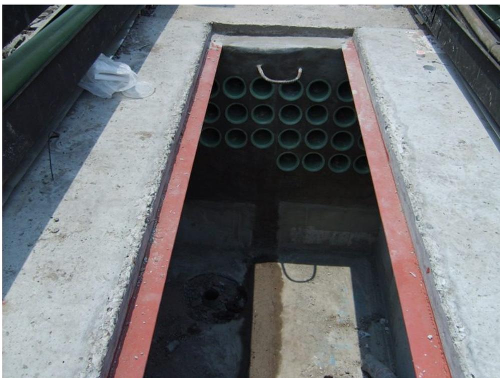
Figura III.31 Emboquillado en registros
