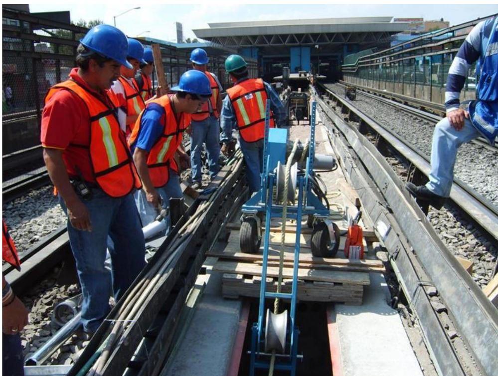
Figura III.39 Malacate eléctrico para el jalado del cable con una fuerza y velocidad constante.
