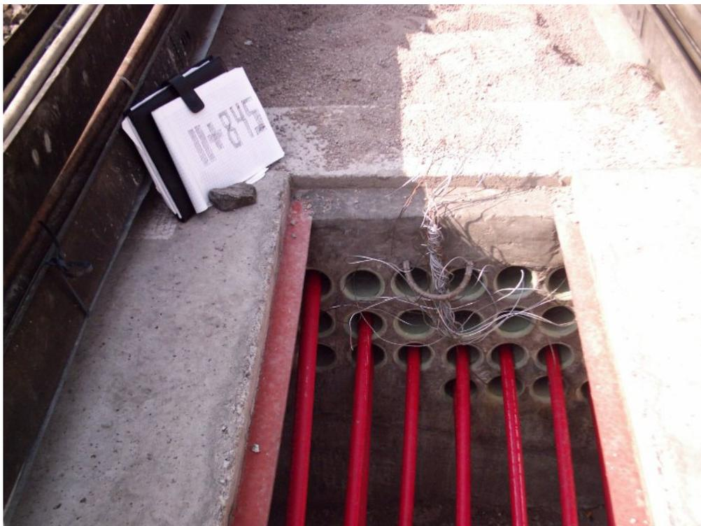
Figura III.41 Cables de 23 kv en interior de ductos de PVC de 4"
