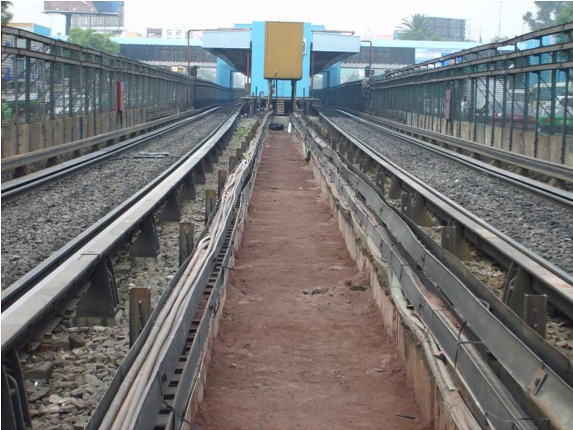
Figura III.16 Colocación de cama de arena.
