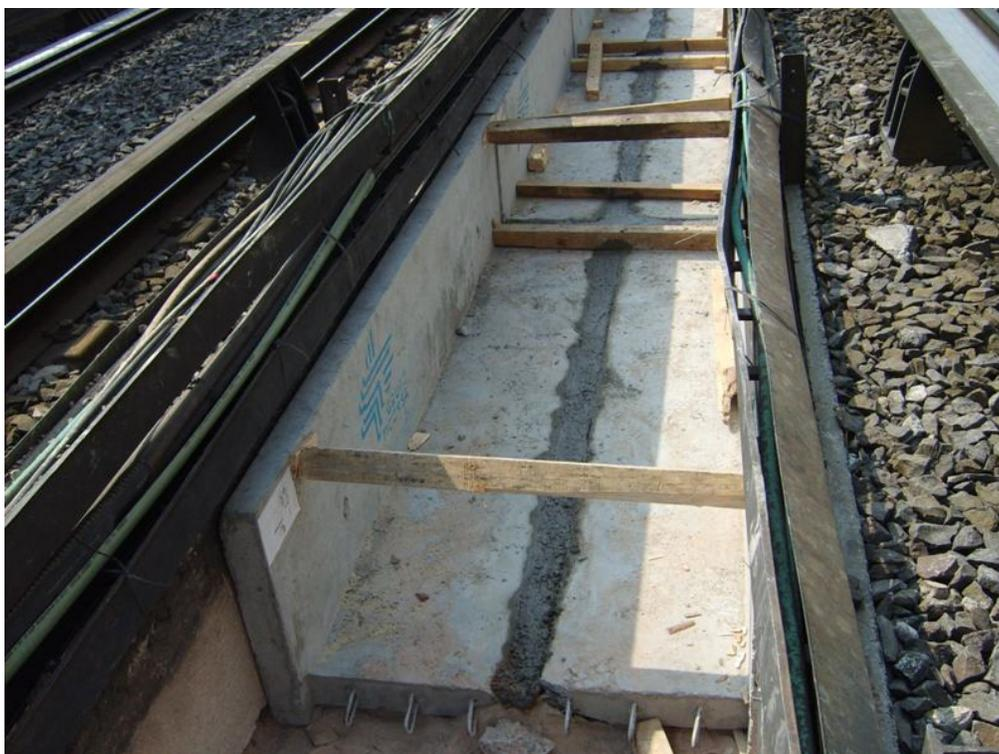
Figura III.25 Vista de andador central con prefabricados apuntalados.
