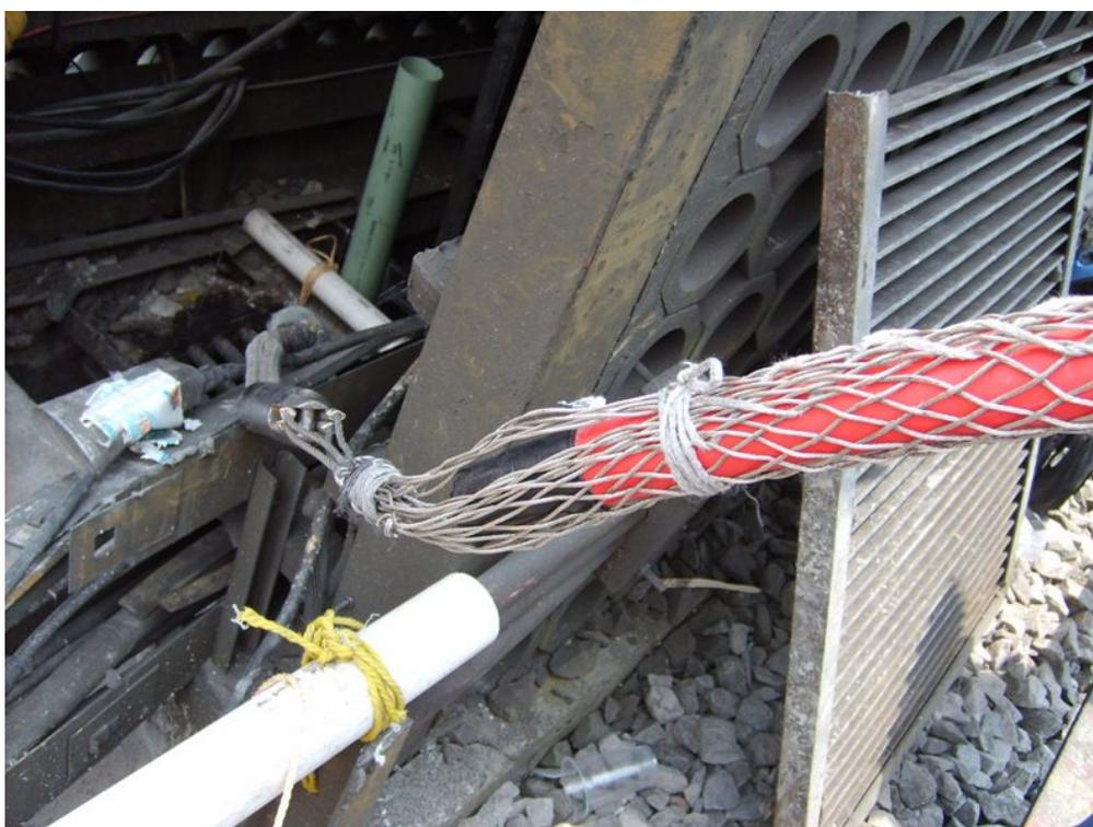
Figura III.37 Cobra para jalado de cable.
