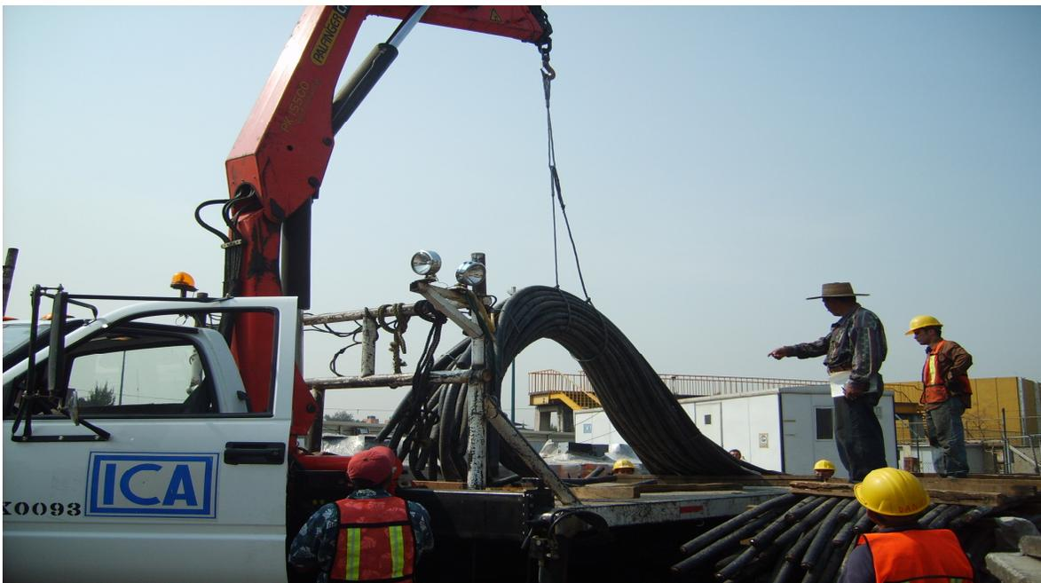
Figura III.8 Entrega de cable tripolar en almacenes del S.T.C.
