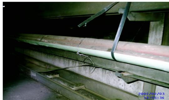
Figura III.2 Colganteo de cables de 23 kv.
