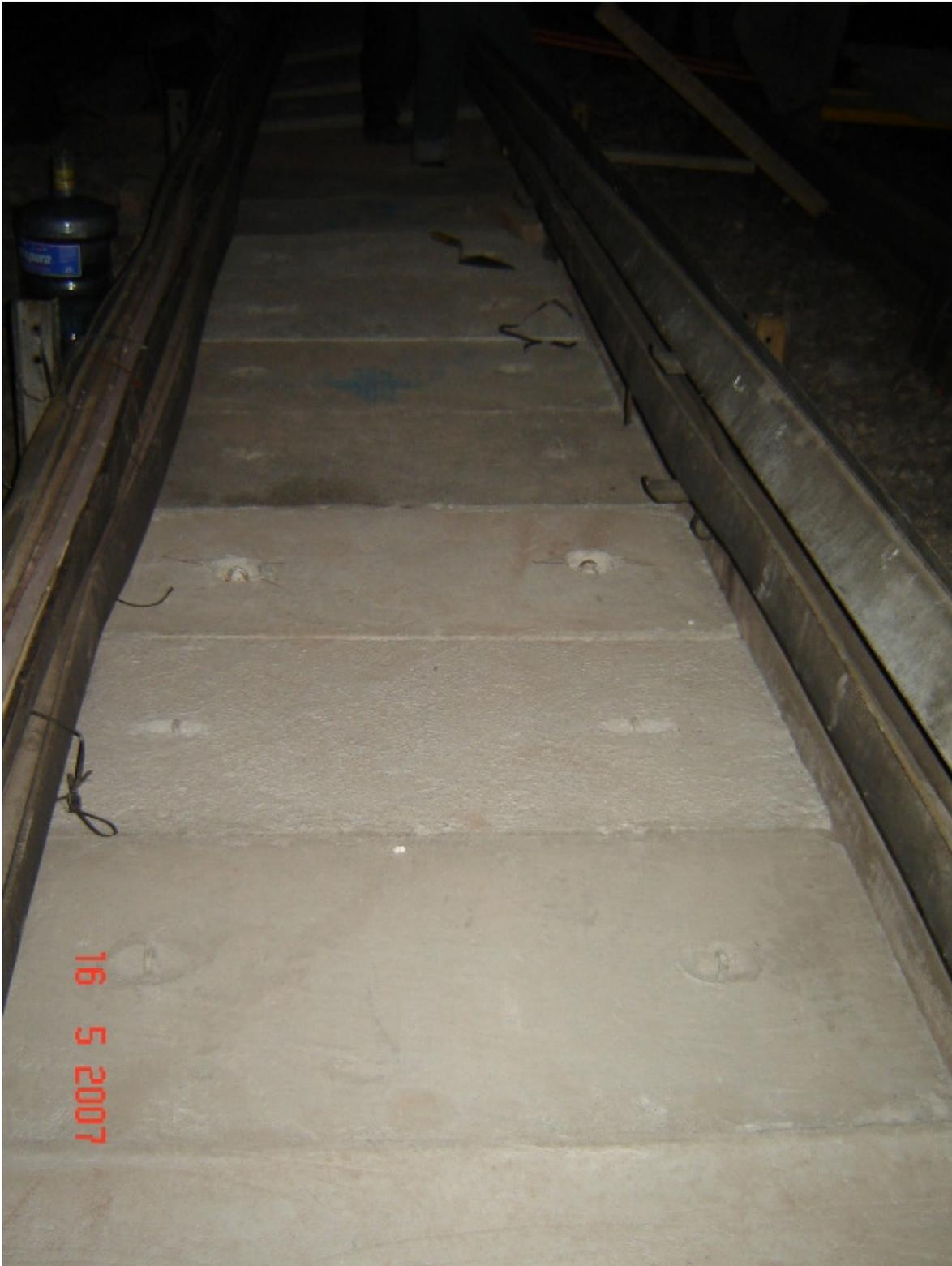
Figura III.34 Vista de andador con tapas de concreto colocadas en sitio.
