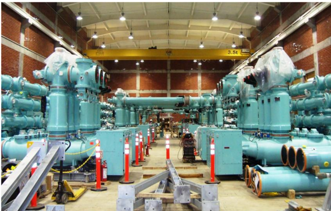
Otra imagen frontal del proceso de montaje de la GIS.
