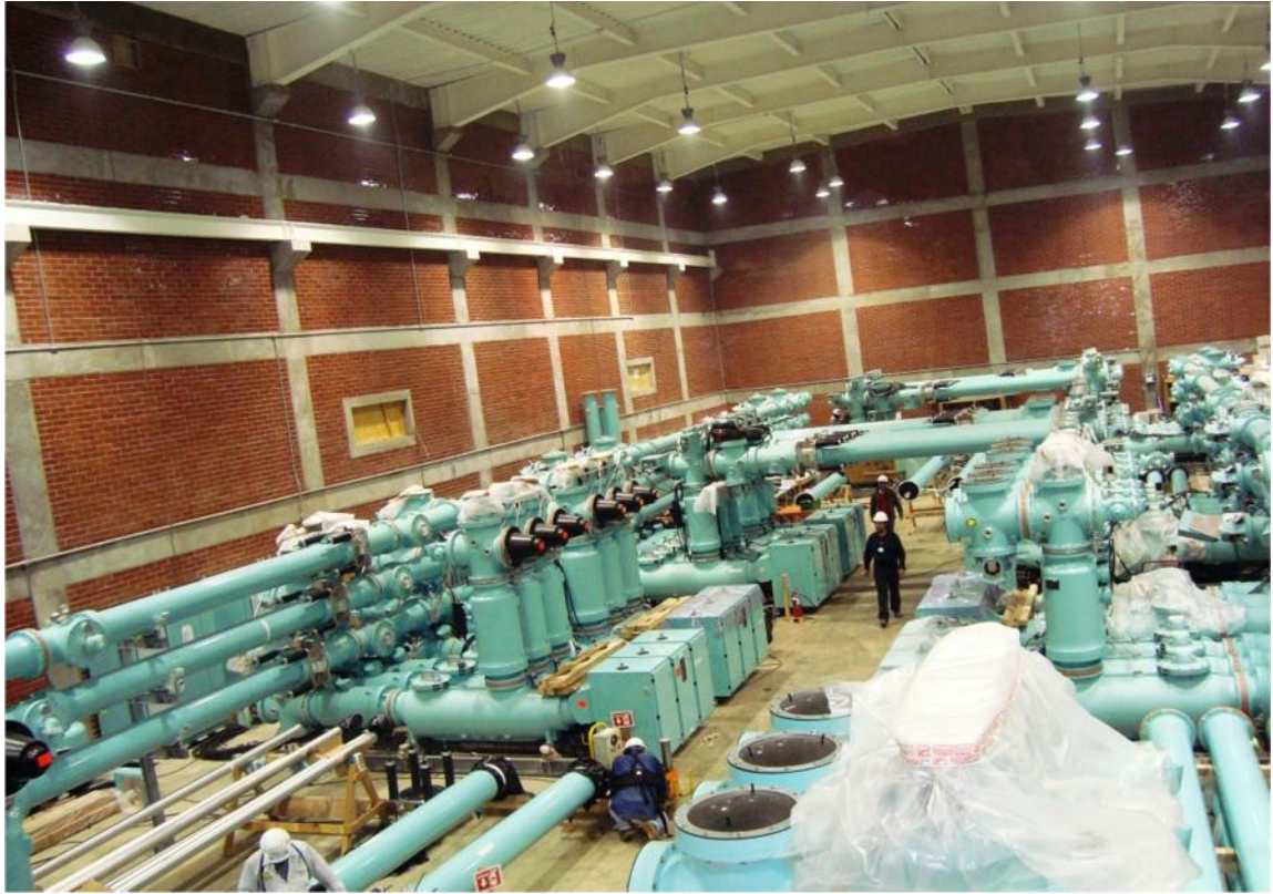
Proceso de montaje de la GIS, aún no se habían interconectado la totalidad de las celdas.
