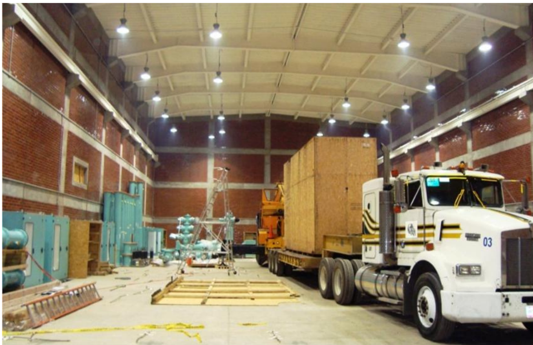
Ingreso de equipos al edificio de la subestación.
