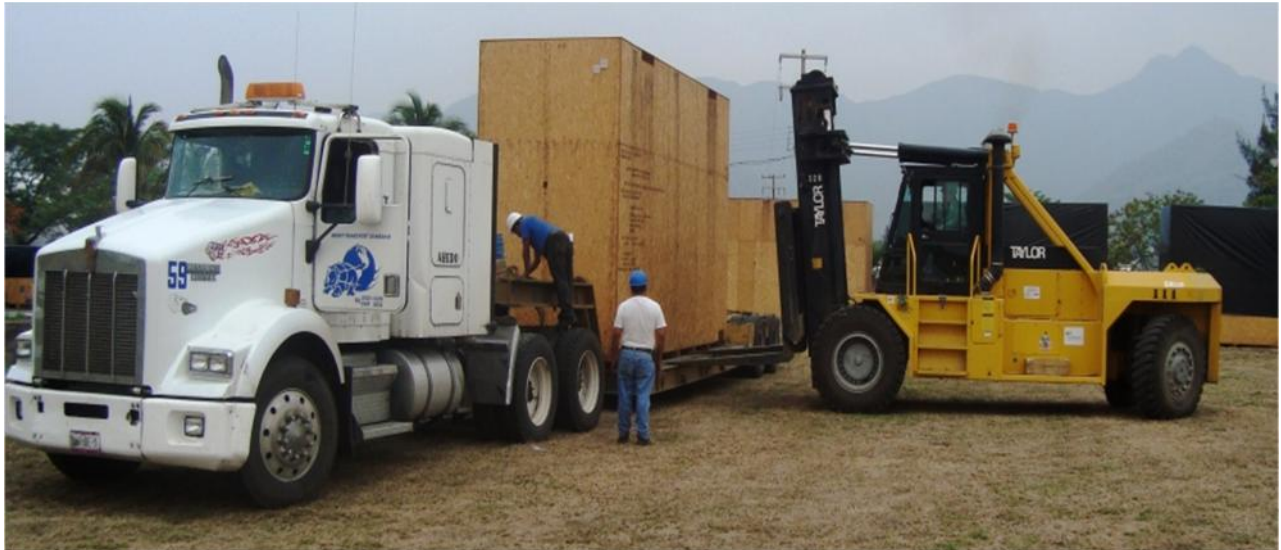
Maniobras de descarga de los interruptores
