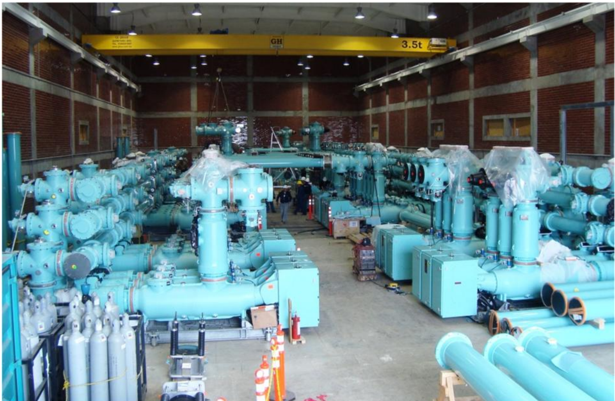
Imágenes finales del proceso de montaje de la GIS
