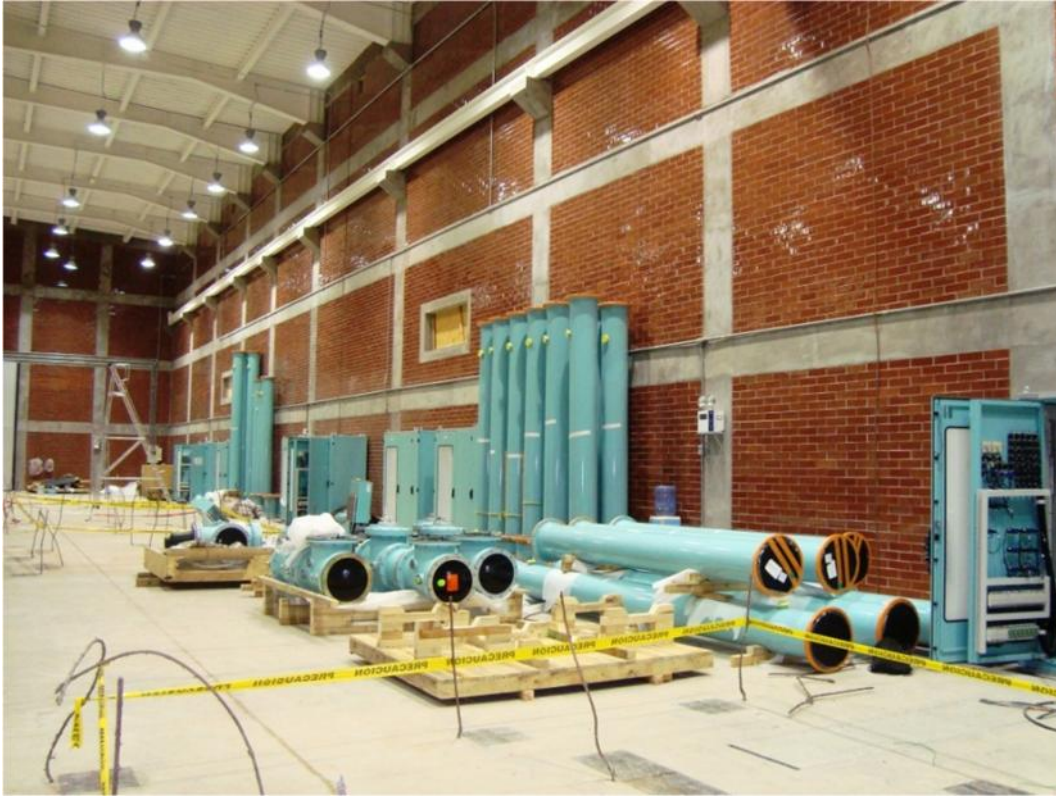
Equipos y accesorios que se instalaron en el montaje.
