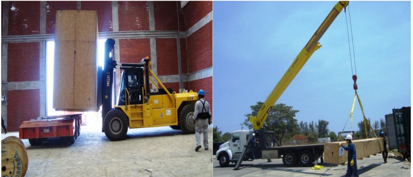
Maniobras de descarga y traslado de equipos.
