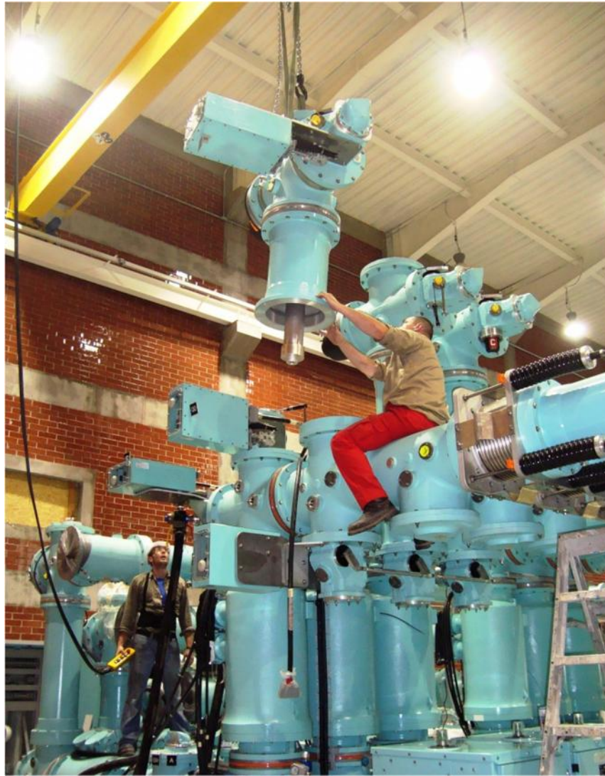
Maniobras de interconexión de celdas
