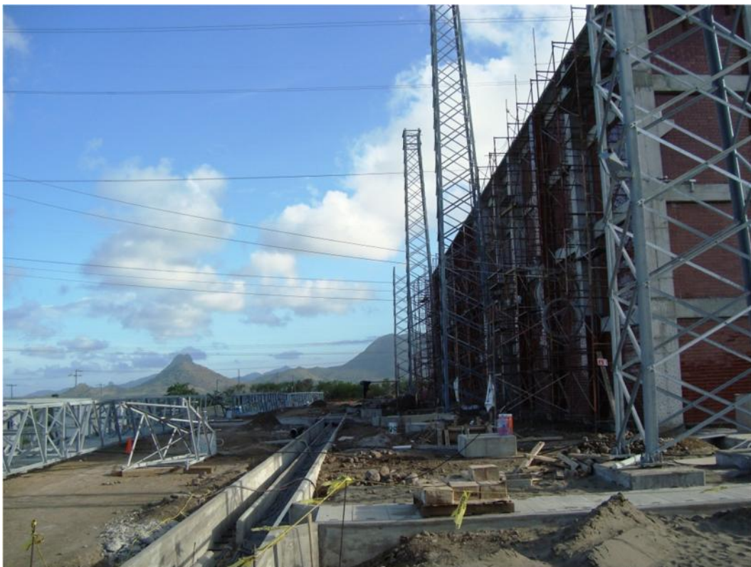
Costado externo del edificio en construcción para la subestación encapsulada
