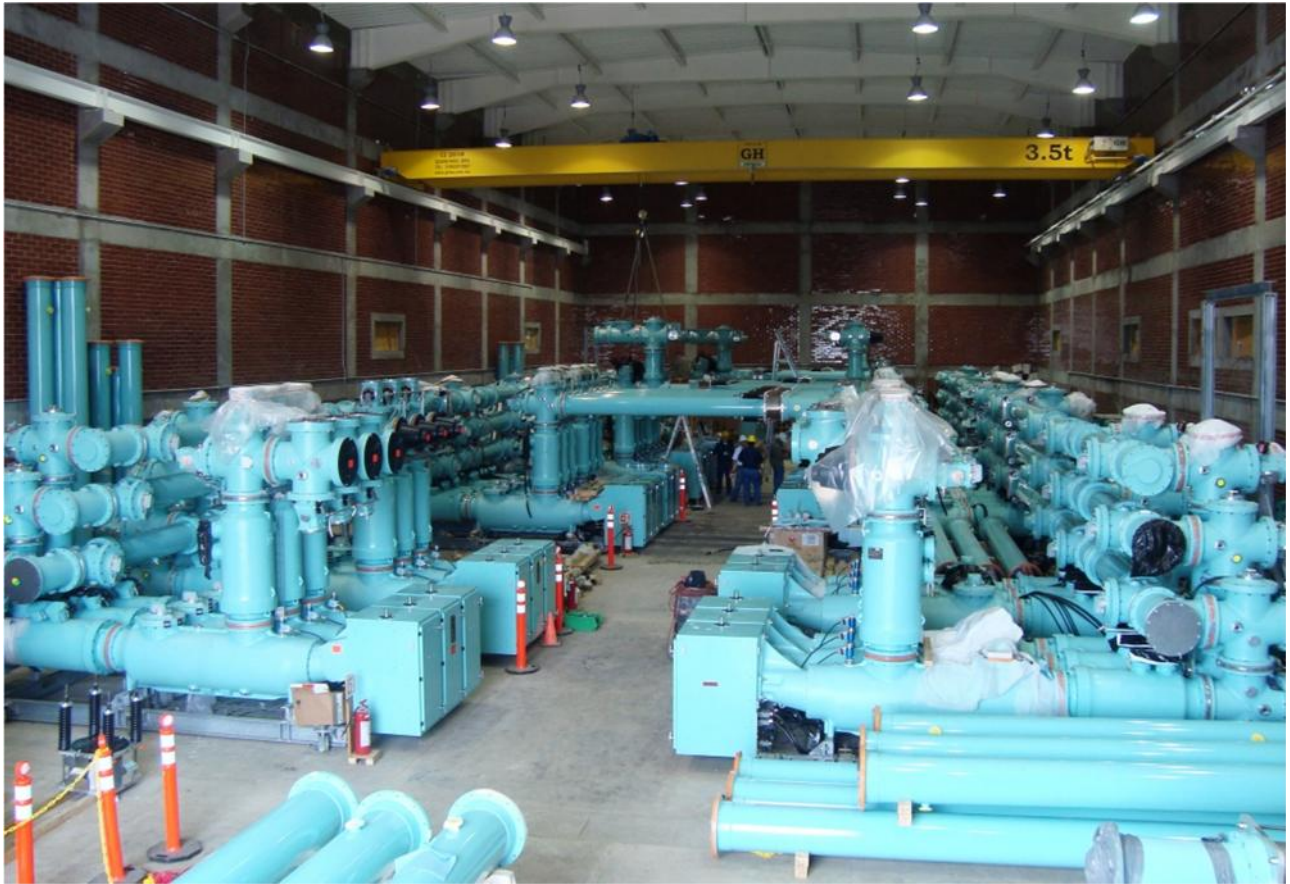
Imágenes finales del proceso de montaje de la GIS
