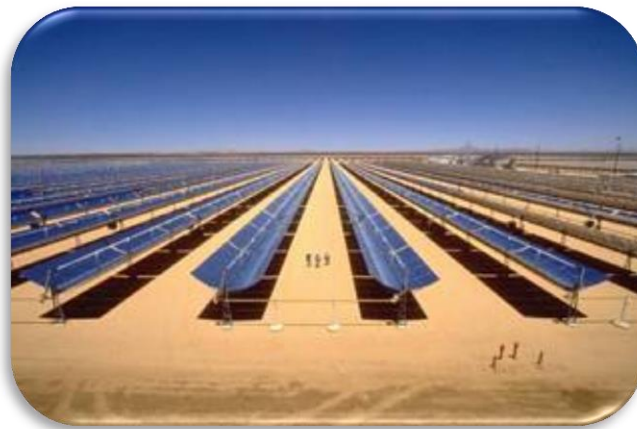
Imagen 1.18 Canales parabólicos de la planta SEGS, Desierto de Monjave en California, Estados Unidos [ Nextera energy resources, www.nexteraenergyresources.com ]
