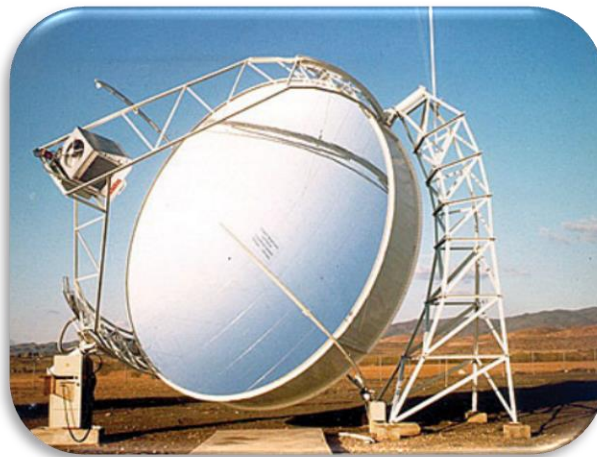
Imagen 1.10. Concentrador Distal I en operación planta de Almería, España [Plataforma Solar de Almería PSA online, www.psa.es ]
