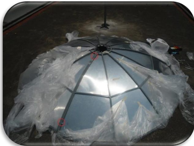
Imagen 2.9. Partes donde se fijan los segmentos
