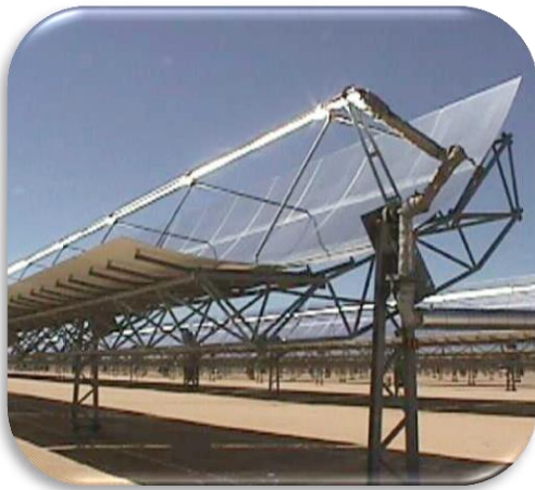
Imagen 1.17 Planta solar de canal parabólico SEGS, Desierto de Monjave en California, Estados Unidos [ Nextera energy resources, www.nexteraenergyresources.com ]
