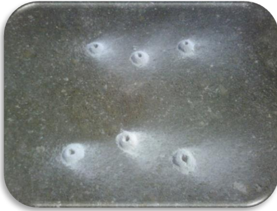
Imagen 2.4 Perforaciones recién hechas en el concreto
