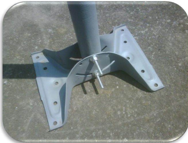
Imagen 2.3. Base del concentrador antes de ser fijada
