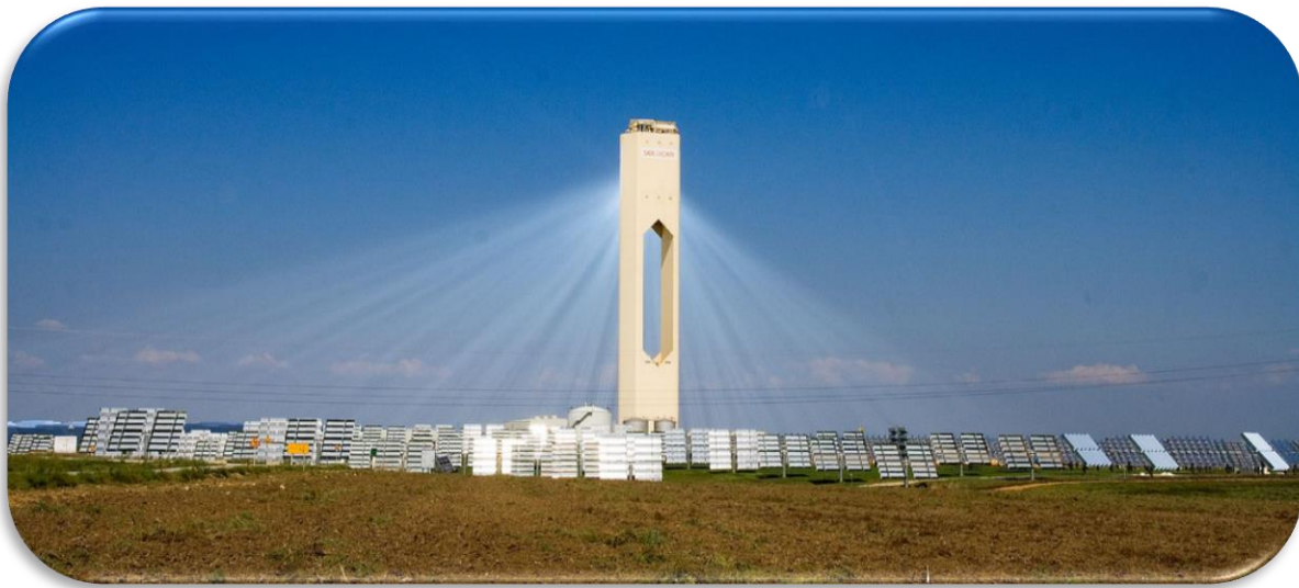
Imagen 1.14 Planta solar PS10 en operación en Solúcar, Sevilla [Abengoa Solar, 2011 ,www.abengoasolar.com]
