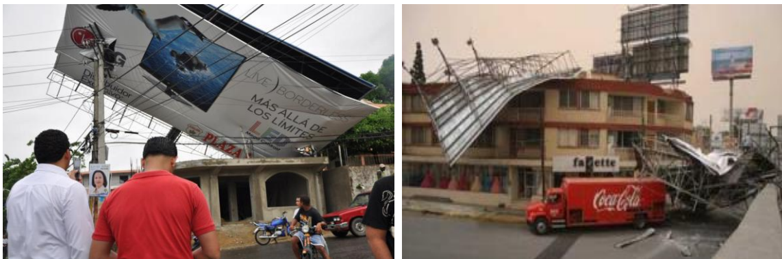
Figura 2.2 Letreros derribados sobre el tendido eléctrico.
