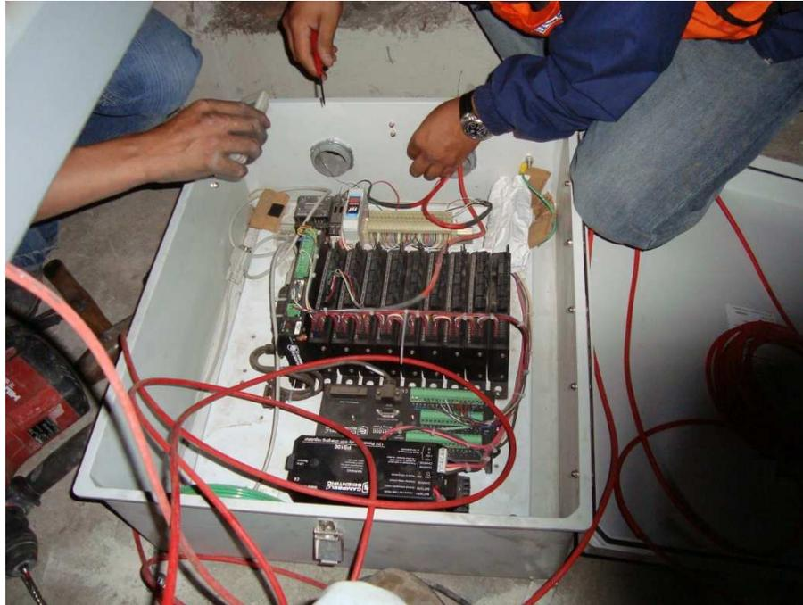
**Fig. 7 Datalogger utilizado para la automatización de los tilt meters.**
