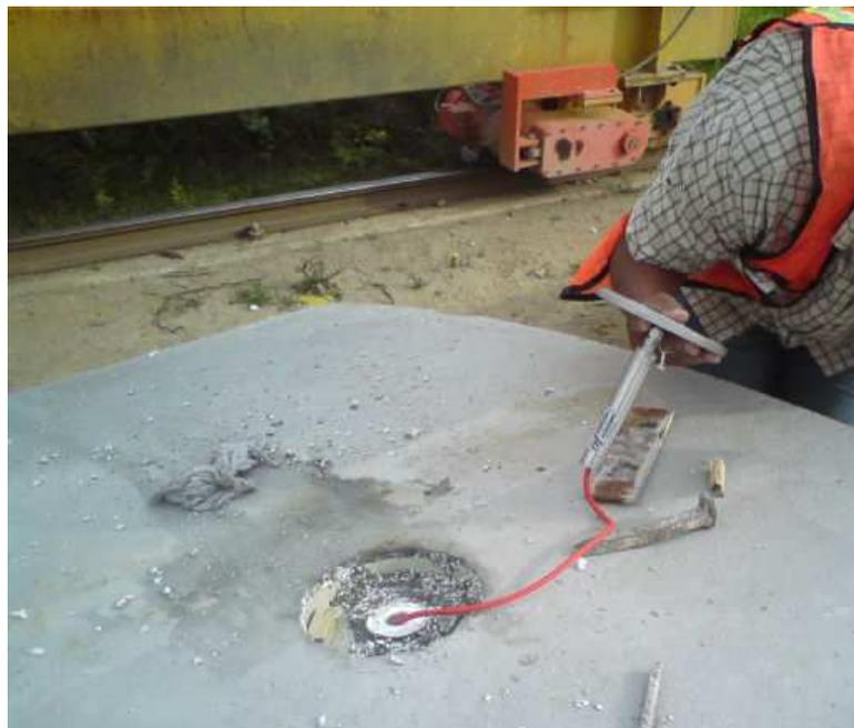
**Fig. 5 Celda de presión colocada en dovela.**
