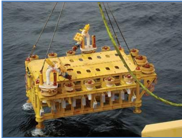
Figura 5- 12 Instalación de un manifold en el campo Azurita.
