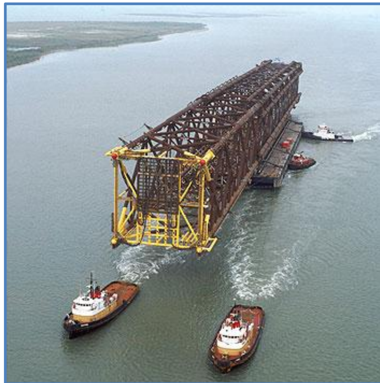
Figura 2- 7 Transportación para instalar una plataforma flexible.
