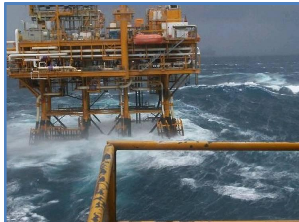
Figura 2- 2 Plataforma en la Sonda de Campeche afectada por el oleaje.
