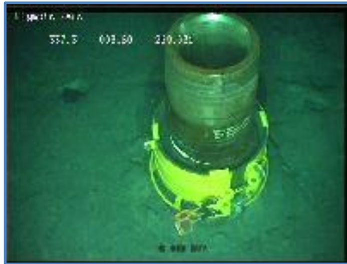
Figura 2- 18 Cabezal submarino instalado en el lecho marino.
