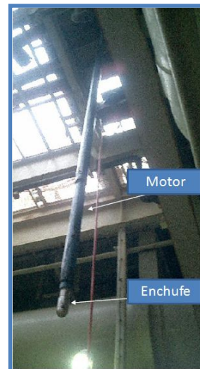
Figura 3- 27 Instalación del BEC por riser.
