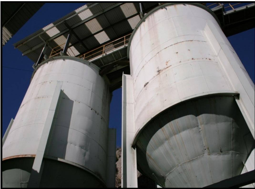
Foto 16.- Silos de almacenamiento de finos (2) de 450 ton de capacidad c/u.
