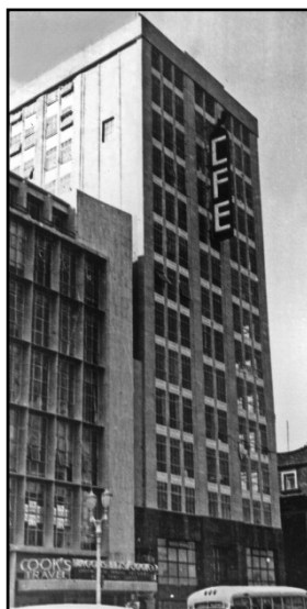
Imagen 1.1. Edificio propiedad de CFE ubicado en Av. Juárez.
