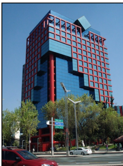
Imagen 1.4. Edificio ubicado en Av. Paseo de la Reforma no. 164.
