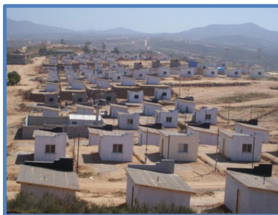
Construcción de Pies de Casa
