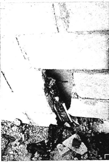
Colocación de plomería y electricidad sin ningún cuidado en la estructura de los muros
