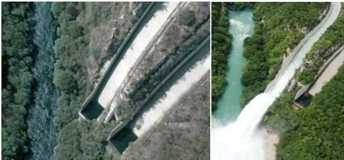
Figura 2.23. Sección terminal del vertedor en salto de esquí.
