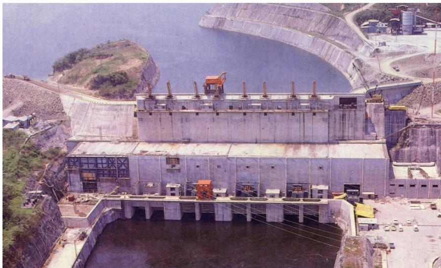
Figura 2.38 (a). Casa de máquinas (perfil). Presa Peñitas.
