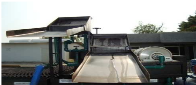
Figura 3. 2 Fotografía de pretratamiento con cribas
