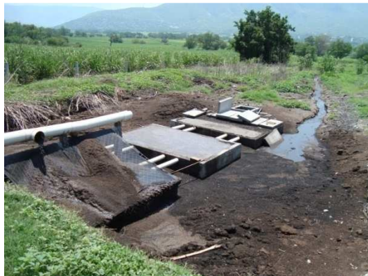
Figura 6. Fotografía de la salida del agua residual que proviene de la granja porcícola
