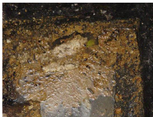
Figura 3.13 Grasas y aceites en el registro de la línea de drenaje de cocina.
