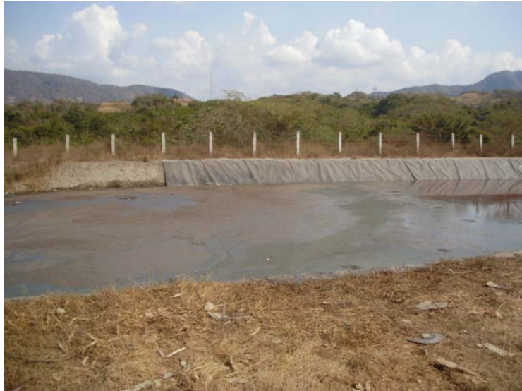
Figura 3.22 Lechos de secado en el relleno controlado municipal.
