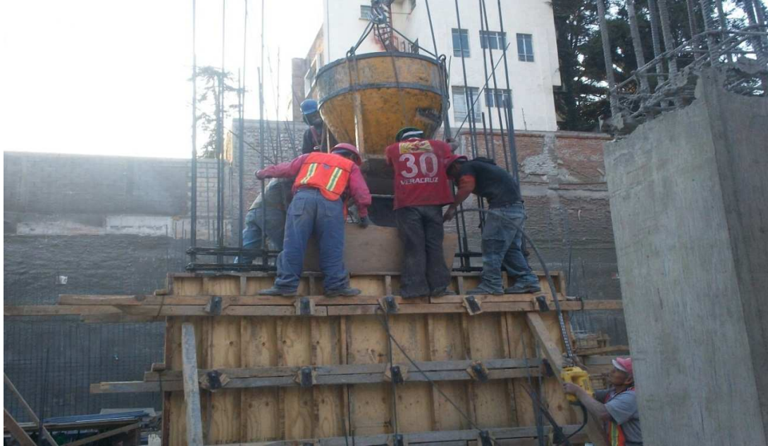
Colado de columnas
