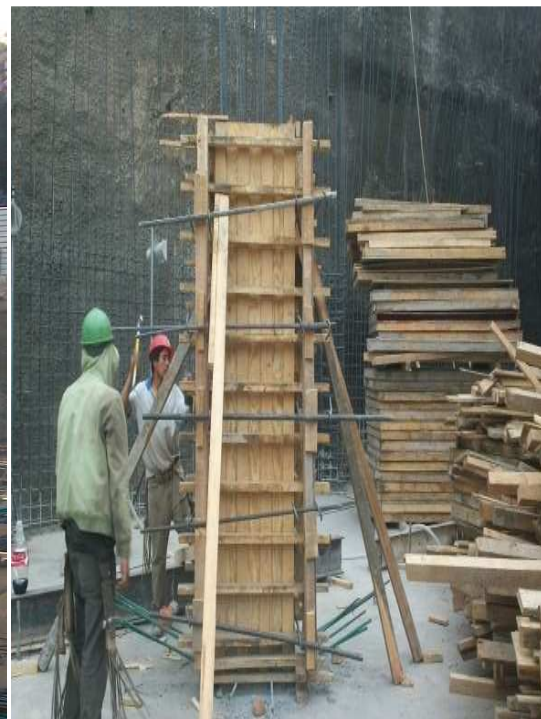
Cimbrado de columnas.
