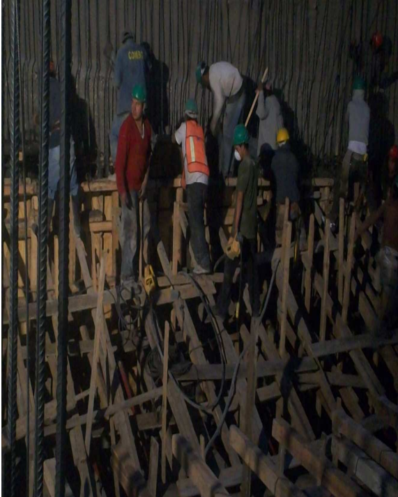
Colado de muro perimetral.
