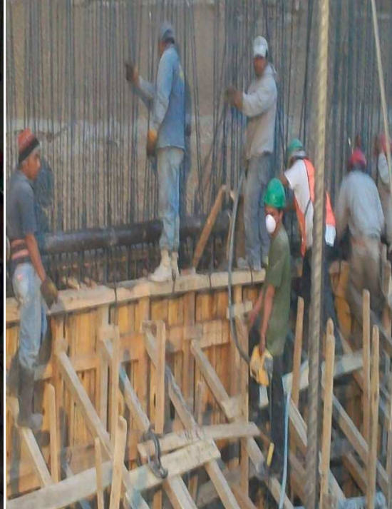
Vibrado de muro perimetral.
