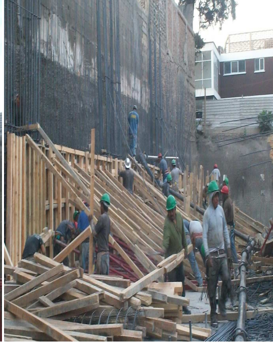
Cimbra de madera.
