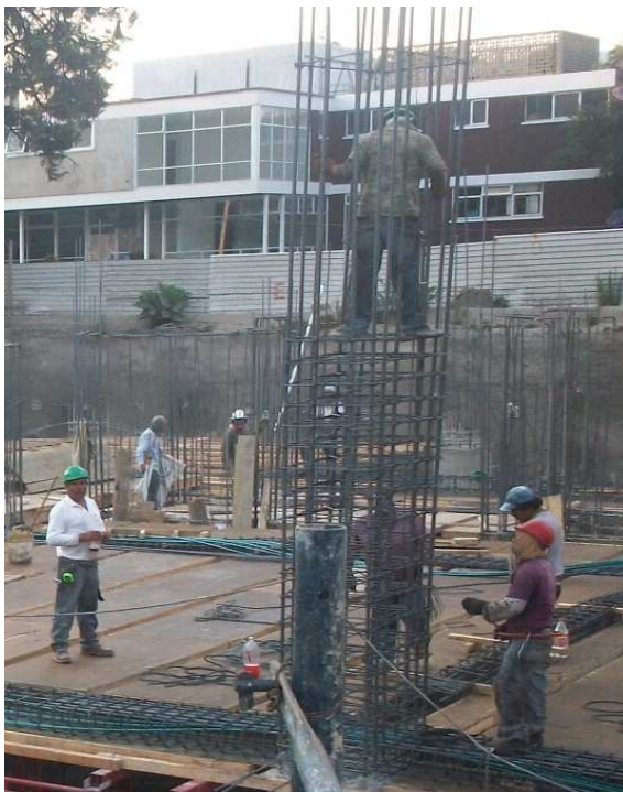
Habilitado de acero para columnas.
