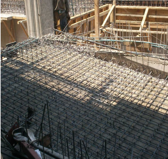
Habilitado de acero en rampa.
