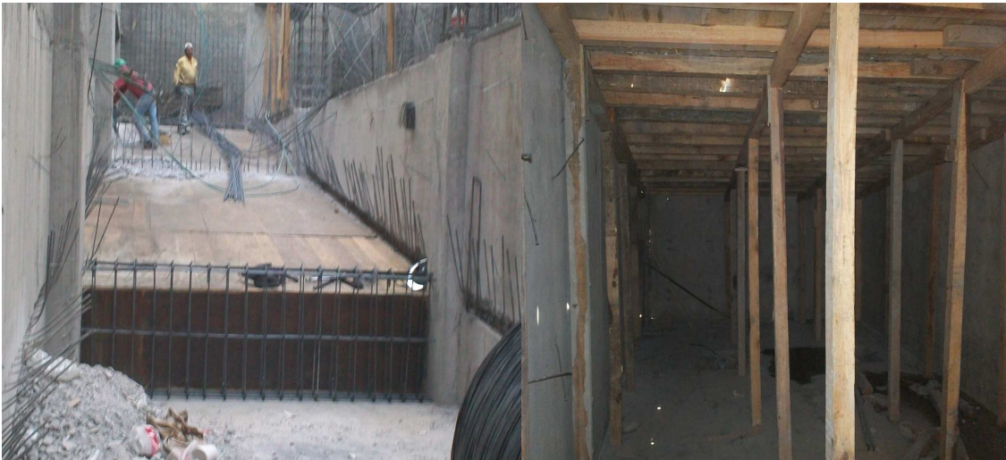
Rampa cimbrada (exterior).
