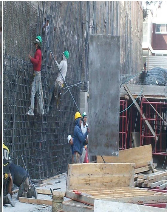
Cimbra para colindancias.
