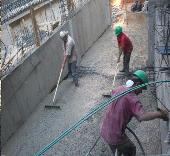
Colado de rampa.
