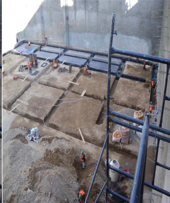
Excavación para contratrabes.
