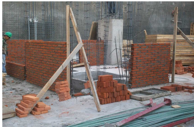
Construcción foso elevador
