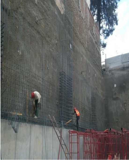
Habilitado de acero en muros.
