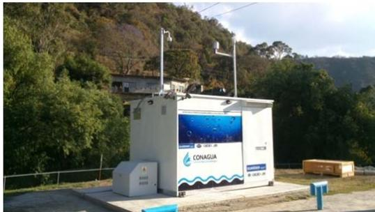
Ilustración 64: Estación de calidad del agua y meteorológica, en planta de tratamiento Valle de Bravo.
