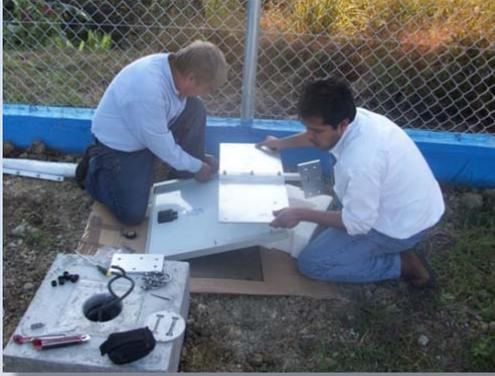
Ensamble de base de sujeción e instalación del panel solar.
