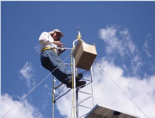
Fijación y nivelación del sensor de dirección y velocidad del viento.
