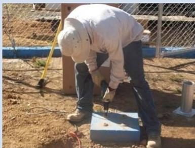
Barrenado de dado para fijación de soporte de sensor de precipitación.
