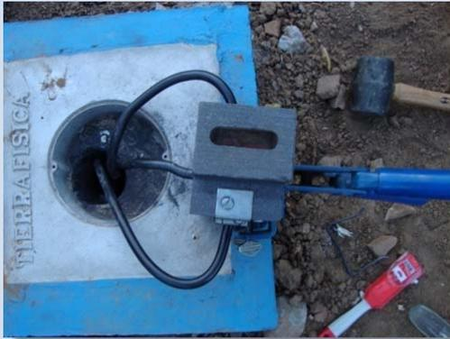
Soldadura de cables de puesta a tierra.
