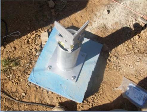
Fijación y nivelación de soporte de Sensor de Precipitación.
