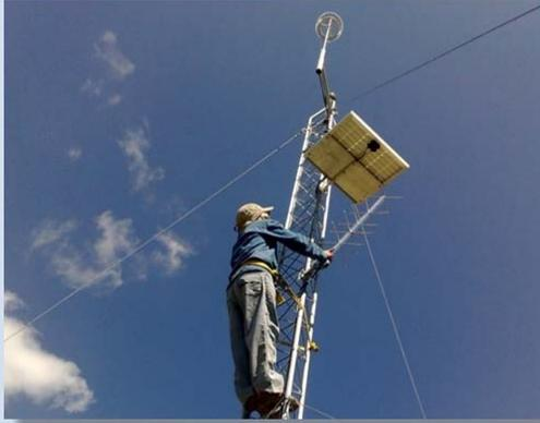
Fijación, orientación y nivelación de antena Yagi.
