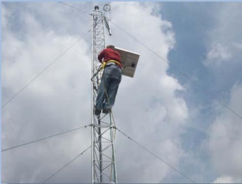
Fijación y orientación del panel solar.
