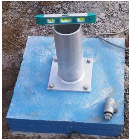
*Ilustración 45: Base de aluminio para sensor de precipitación*
