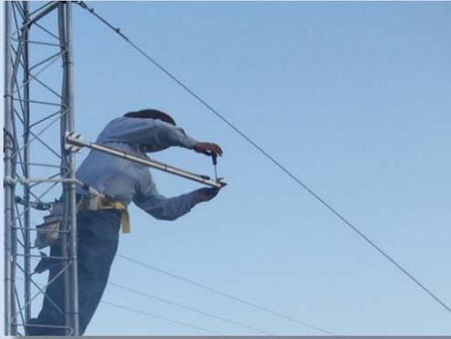
Ajuste y nivelación de Sensor del Radiación Solar.
