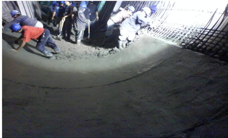
**Fig. 4.2.14. Colocación de concreto en zona de cubeta**
