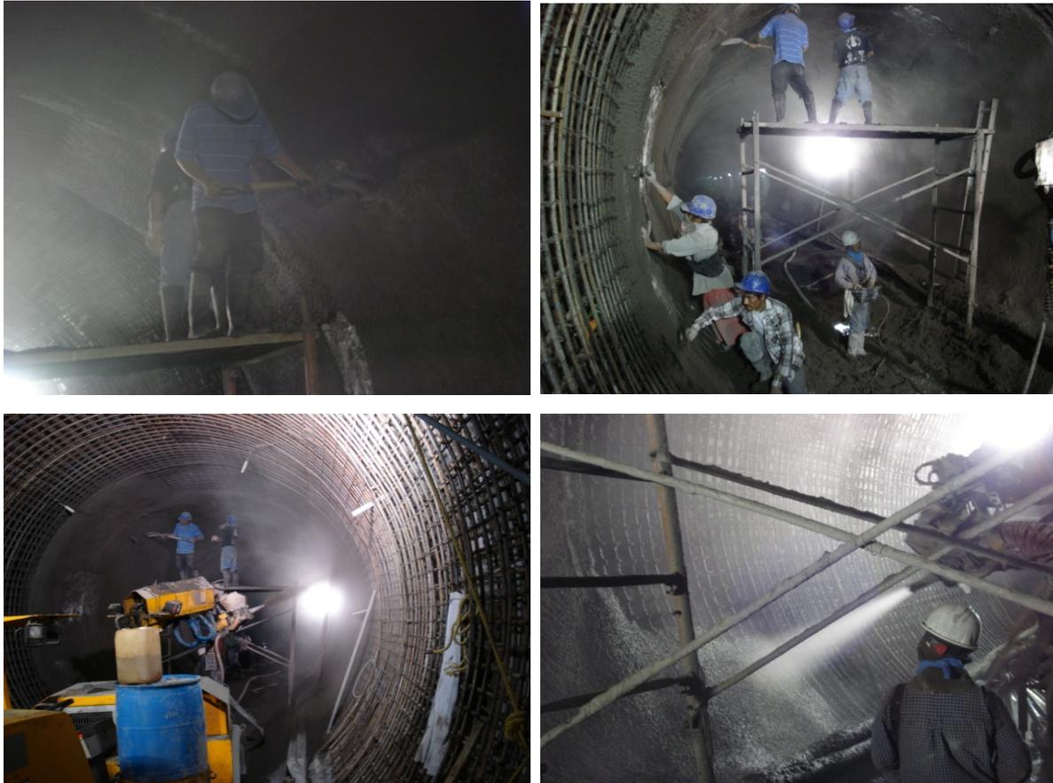
**Fig. 4.2.15. Colocación de concreto lanzado**
