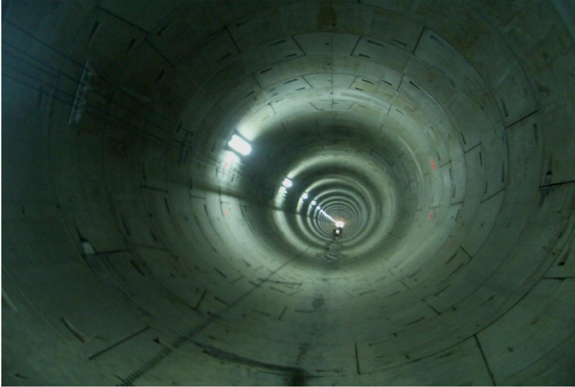
Conforme se avanza en la colocación de los anillos se requiere de una inyección a través de preparaciones que se dejan para este propósito en la clave del anillo, tal inyección es a base de mortero y bentonita, con la finalidad de rellenar los espacios anulares y limitar los asentamientos del terreno (efecto autonivelante) que quedan entre las dovelas y el terreno al liberar el faldón del escudo, la inyección también ayuda a impermeabilizar el túnel.
