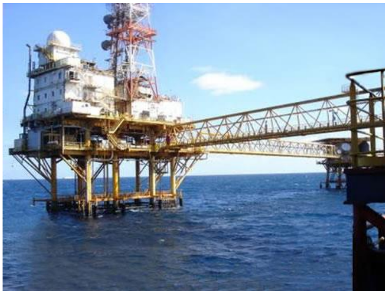
Figura 1.9 Plataforma de Enlace
