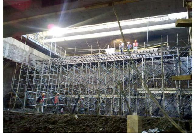
a) Armado y colado de losa mezzanine
