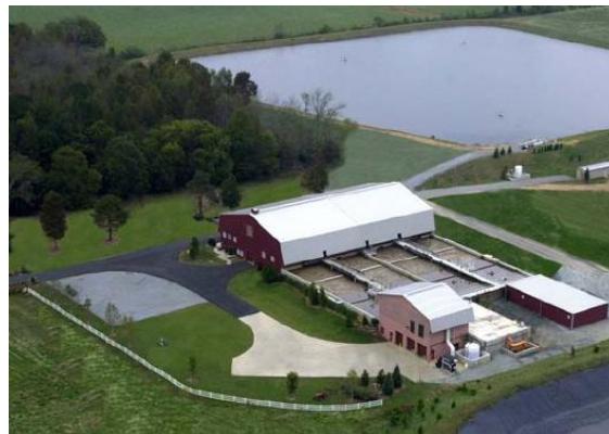
Figura 2.3 – Imagen aérea de la planta de tratamiento de agua residual. (EDT, 2009)
