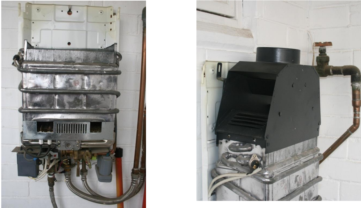
Figura 21: Componentes del calentador de paso instantáneo TEKTINO
