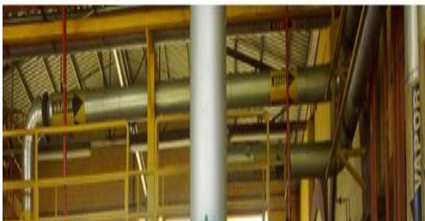
**Figura 3. 4 Ductos para vapor.**
