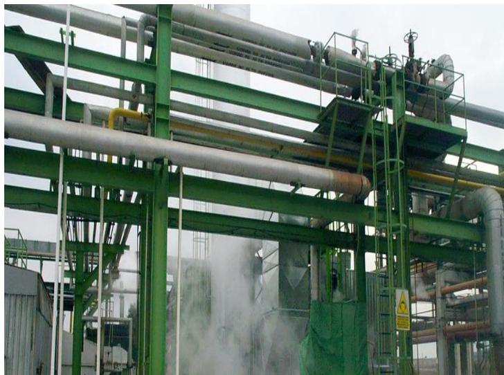
**Figura 2. 3 Sistema de distribución de vapor.**
