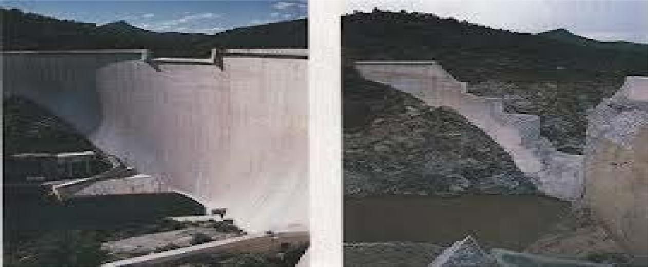
Fig. 3.5. Presa Mallpasett antes y después de la falla
