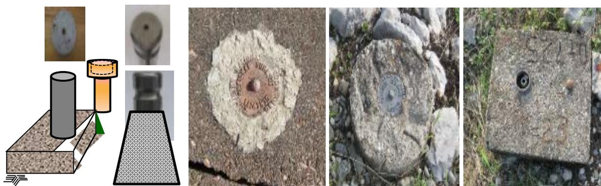
Fig. II.12 Referencias topográficas
