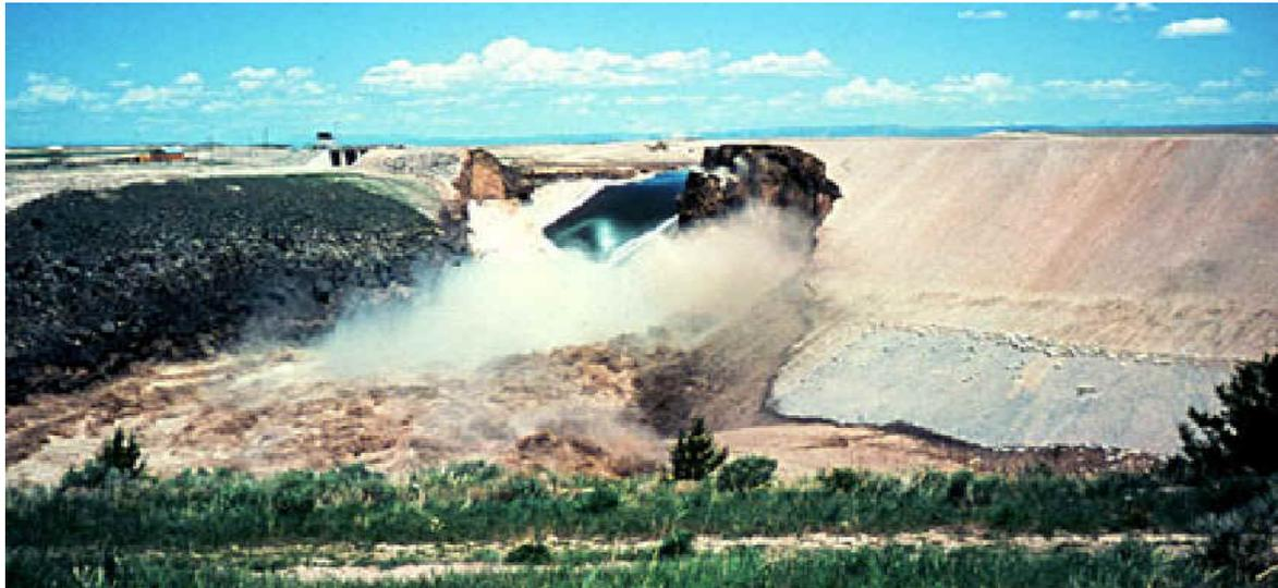
Fig. 3.6. Falla de la Presa Teton
