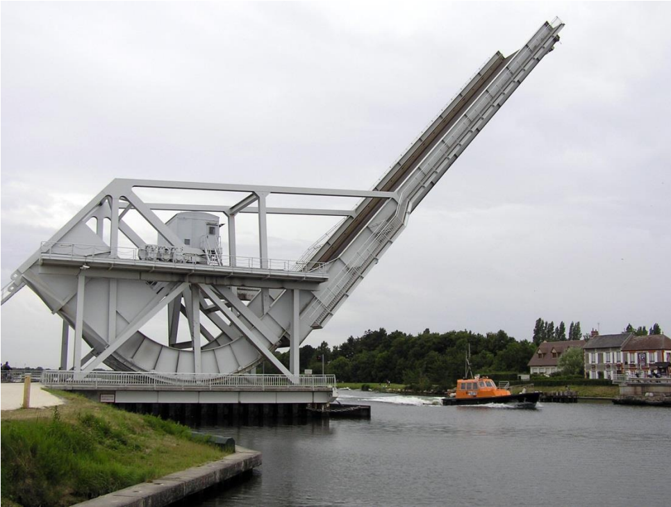
Figura 49 Puente Pegasus en Francia
