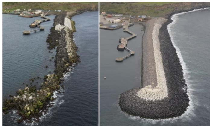
Fig.1.5 Reparación del rompeolas en las islas Azores (Tomada de http://www.baird.com )
