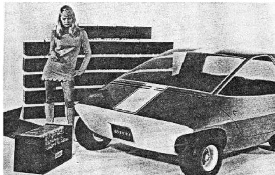
Figura 1.2. AMC Amitron y su caja de baterías de litio. (ref. 1)
