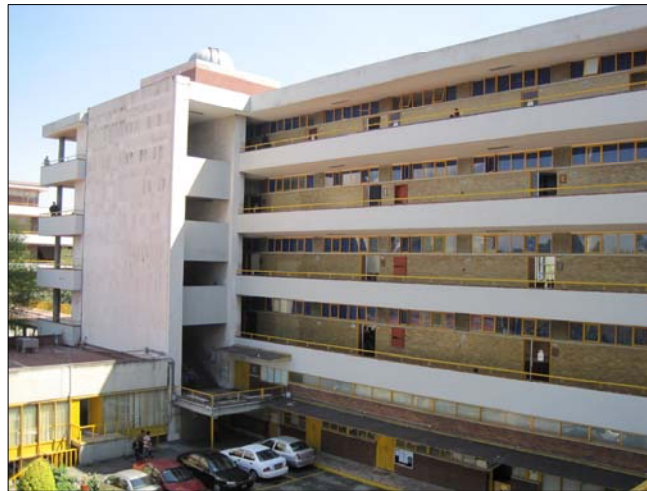
FOTOGRAFIA 2.6 FACHADAS NORTE Y PONIENTE
