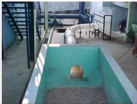
Foto 4. Portal de salida del túnel de desfogue
