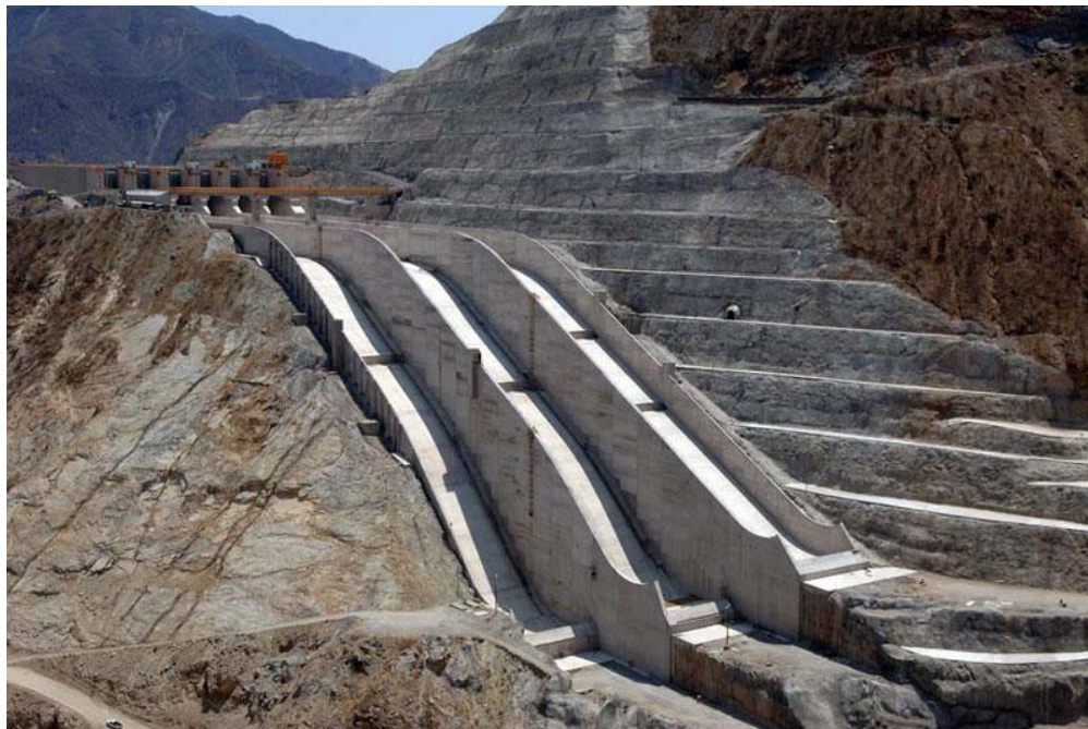
Fig. 2.3. Canal de descarga del vertedor de la Central hidroeléctrica la Yesca.
