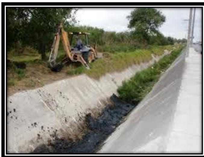
Limpieza de estribos, pilas, columnas y aleros. Retirar la vegetación, basura, fragmentos de roca, y todo material que se acumule en la estructura, esta limpieza incluye el cuerpo de los elementos, coronas y los dispositivos de apoyo.
