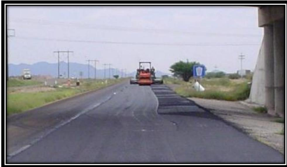
*Carpeta de un riego.* Es la aplicación de un material asfáltico y una capa de material pétreo triturado, de una composición granulométrica determinada, a esto se le conoce como riego, el fin de esto es restablecer o mejorar las características de resistencia al derrapamiento y aumentar la seguridad en la superficie de rodamiento. Pueden ser o no premezcladas.
