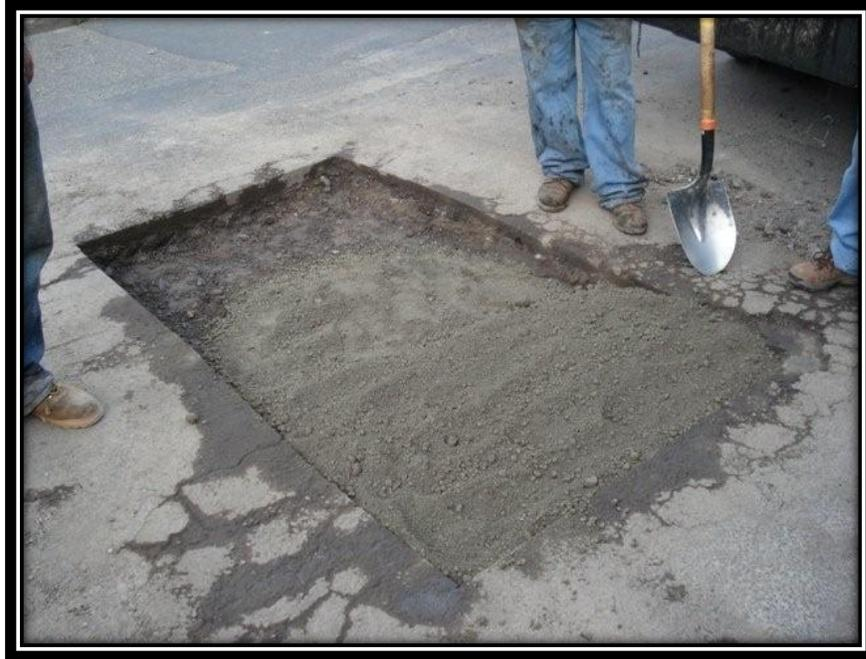
El bacheo se efectuará con mezcla asfáltica, y si la profundidad es mayor a 7 [cm] se rellenara en capas y la capa superficial tendrá entre 4 y 6 [cm] de espesor, las capas inferiores máximo de 10 [cm]; antes de iniciar el relleno se debe dar un riego de liga en las paredes y el piso, las capas deben compactarse con pisón de mano o rodillo ligero, sin dejar el paso de tránsito con la debida compactación.
