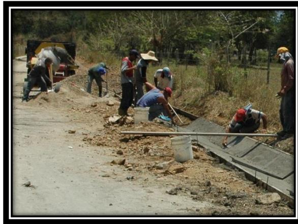
Reparación de alcantarillas y colectores. Es la rehabilitación de los elementos para garantizar el correcto flujo del agua en la carretera.
