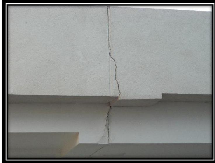
Reparación y resanes en elementos de concreto. Restitución de los elementos de estructuras de concreto hidráulico deteriorado, ya sea por impactos, corrosión, concreto deficiente, degradación del concreto, entre otros. Esta restitución se puede hacer mediante resane o reparación de la sección.
