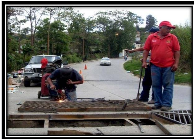
Reparación de lavaderos. Es el cambio o reparación de estos elementos de la carretera para optimizar el cauce del agua evitando que existan fallas por causa del agua.
