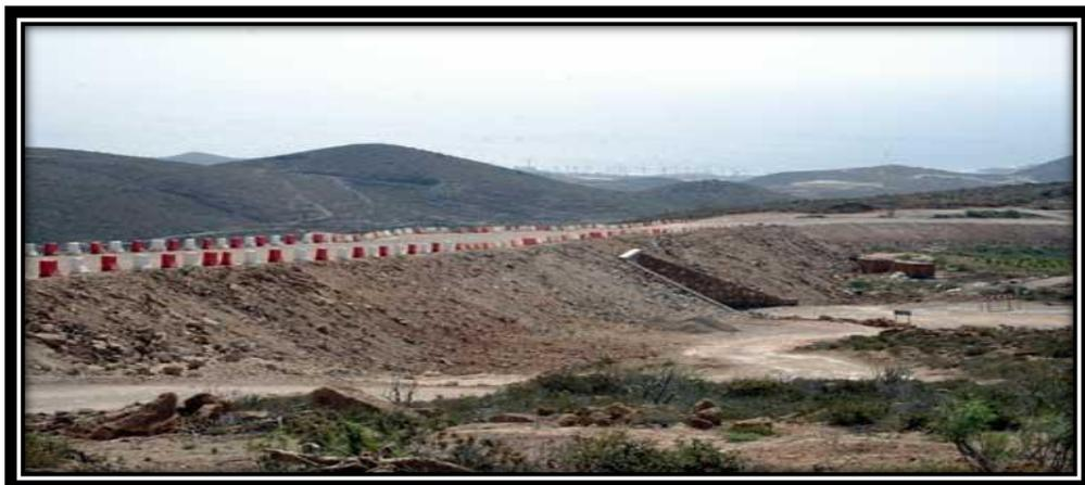
Estos trabajos se deben hacer mínimo cada 6 meses preferentemente antes de la época de lluvia o después para evitar que surjan fallas, para que la sección transversal mantenga el bombeo o la sobre-elevación adecuada, permitiendo una escurrimiento del agua superficial, evitar que la superficie tenga ondulaciones o depresiones y que garantice la transitabilidad del camino aun en época de lluvias.
