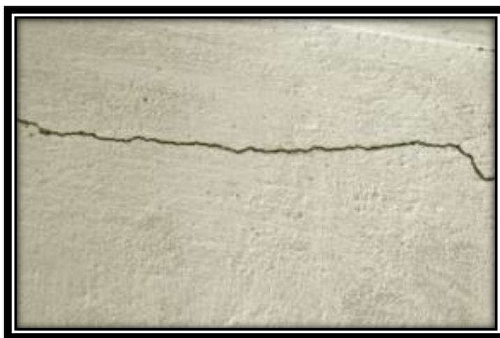
Reparación de grietas. Sellado de fisuras mayores de 0.3 [mm] de grosor que se encuentren en los elementos estructurales de concreto, mediante productos especiales, con el fin de que el acero no entre en contacto con el agua y así evitar su deterioro y degradación.
