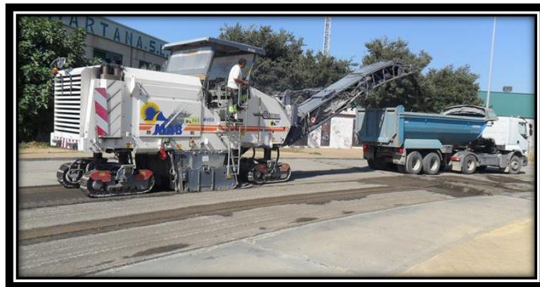
Recorte de carpetas asfálticas. Remoción de la carpeta por medios mecánicos, con la profundidad, ancho y sección requeridos por el proyecto, para así reponer la carpeta y la capa de rodadura.
