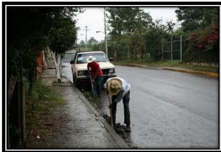
Limpieza de drenes. El propósito es quitar azolve y todo material que se acumule en estos elementos con el propósito de restituir su capacidad y eficiencia hidráulica, esto tiene por objeto evitar encharcamientos en la superficie de rodadura así como la formación de humedades que provoquen el deterioro de los elementos de la superestructura. Los drenes a limpiar son: drenes de piso, drenes de tubo y drenes pluviales.
