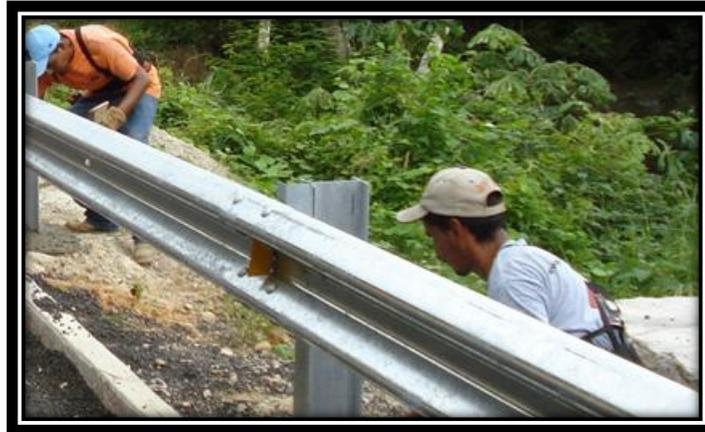
Instalación de señalamientos y dispositivos para protección en obras de conservación. Son las marcas, señales verticales y dispositivos que son colocados de manera temporal, con el fin de garantizar la integridad de los usuarios.
