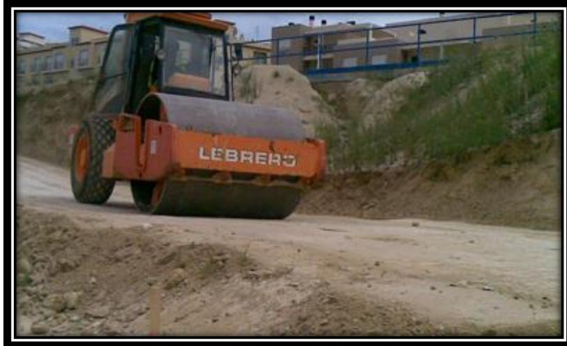
Si después de analizar y llegar a la conclusión de que no se necesita hacer recargue, el rastreo consiste en hacer rebajes en las partes salientes para rellenar las depresiones con ese material, si se considera necesario se hará un riego con agua dejando que penetre y se compacte el material flojo.
