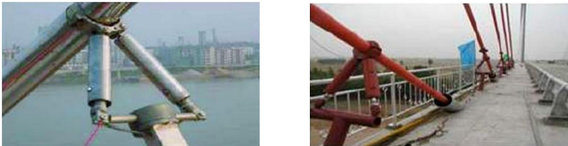
Figura 3.11 (a) Puente Lake Dongting con amortiguador MR; (b) Puente Binzhou con amortiguador MR
