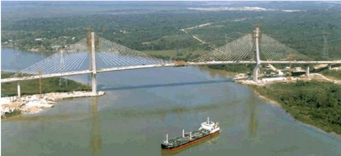
Figura 1.11 Puente Dovalí Jaime (puente con suspensión central o uniaxial)
