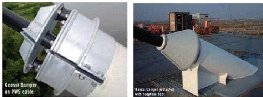
Figura 3.8 Amortiguadores visco-friccionantes
