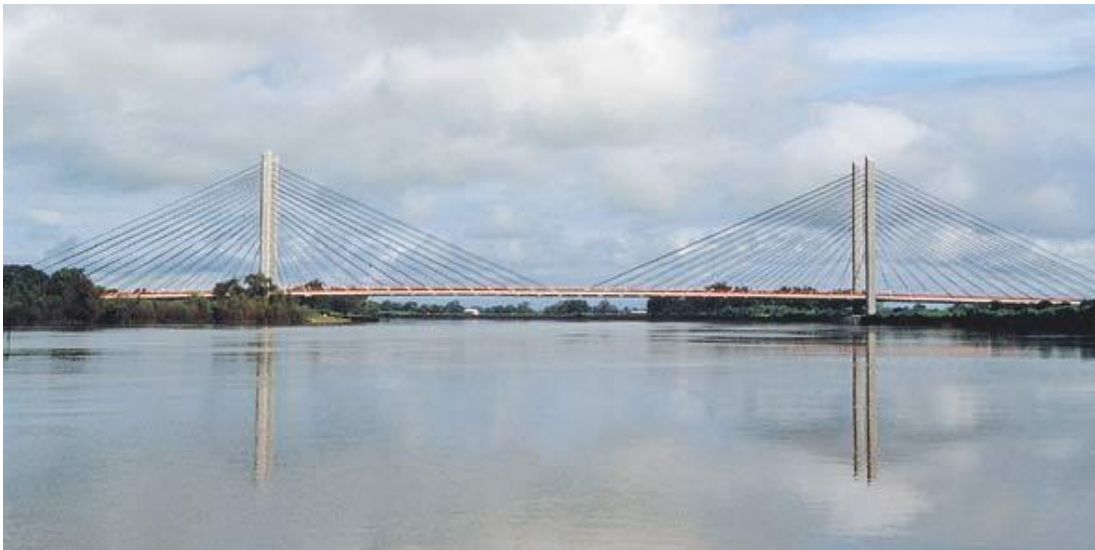
Figura 1.10 Puente río Papaloapan (puente con suspensión lateral)
