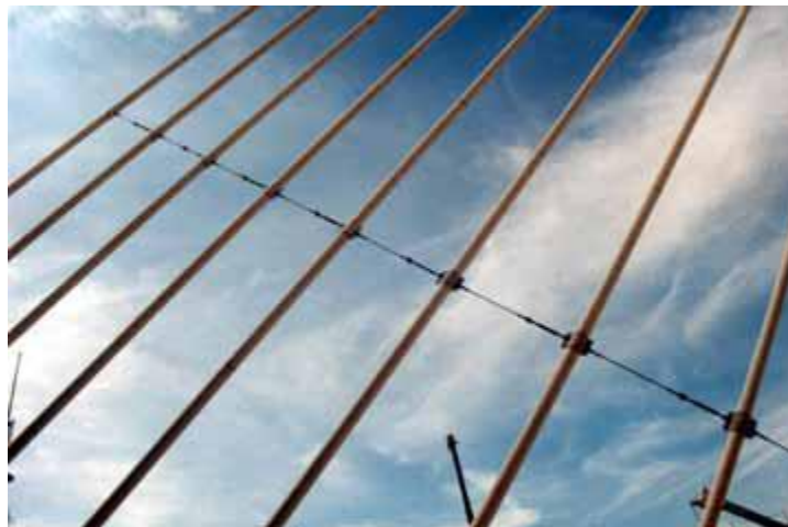
Figura 3.3 Conexión transversal de un cable secundario
