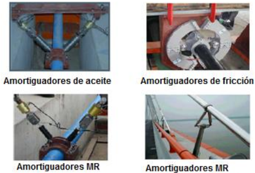
Figura 3.5 Amortiguadores de aceite, amortiguadores de fricción y amortiguadores magnetoreológicos
