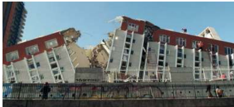
Figura 1.1 Ejemplos de edificios colapsados, Sismo en Pakistán (2005), Sismo en Chile (2010)
