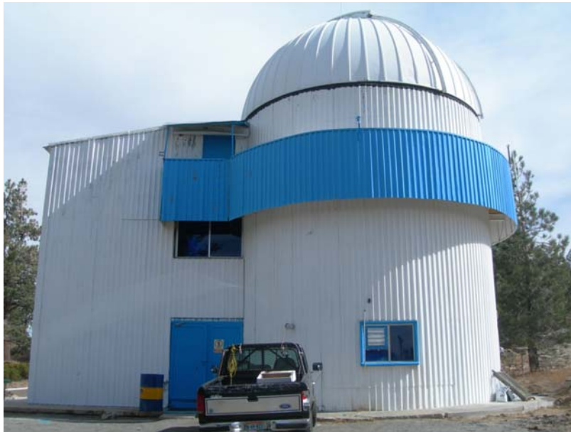
Imagen 1-8 Edificio del Telescopio de 0.84 m.
