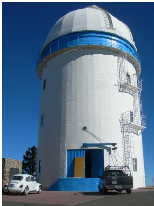
Imagen 1-11 Edificio del telescopio de 2.12 m.
