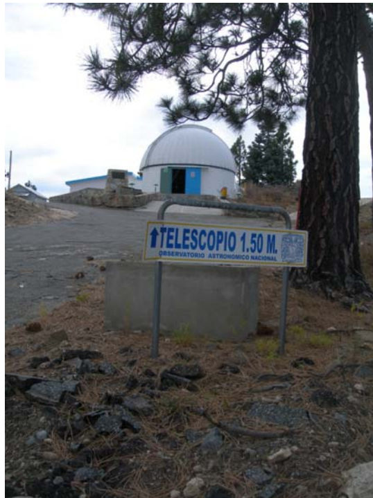
Imagen 1-9 Edificio del telescopio de 1.5 m.
